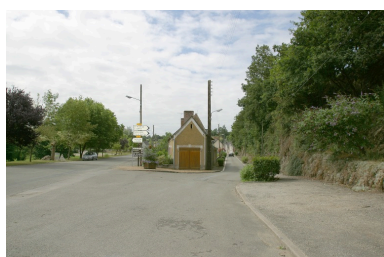
Vue partielle depuis le nord, prise à proximité de l'angle formé par la rue nationale et la rue du moulin. Phot. François Lasa IVR52_20035302361NUCA
