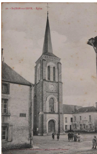
Carte postale, début XXe siècle. La place de l'église vue depuis l'actuelle rue du moulin au nord-ouest. Autr. Pavy-Legeard, Phot. François Lasa IVR52_20035302558NUCA
