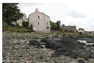
Vue d'ensemble depuis la grève. Phot. François Lasa IVR52_20054401137NUCA
