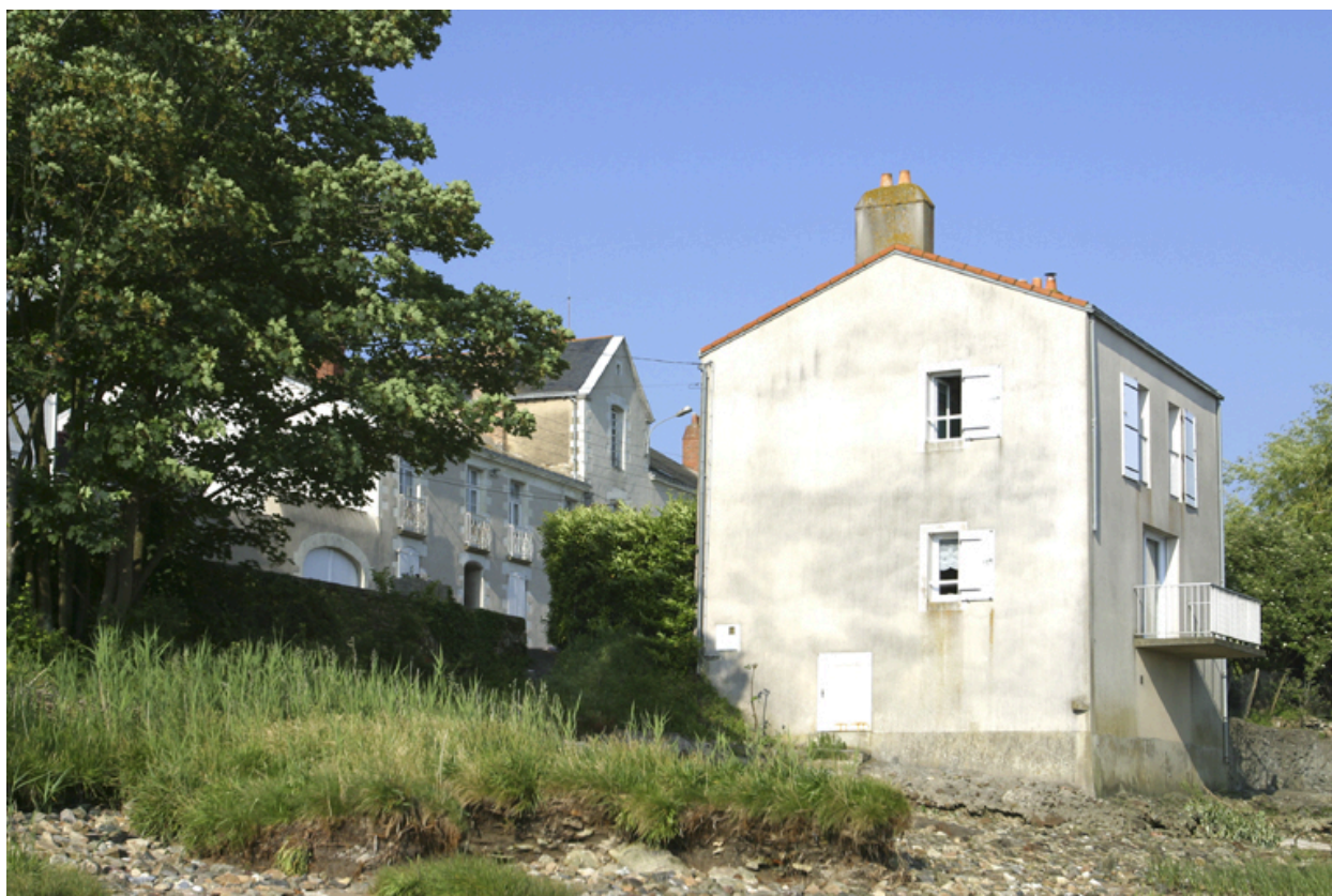
Le pignon et la façade nord du côté de la Loire vus depuis la grève.
