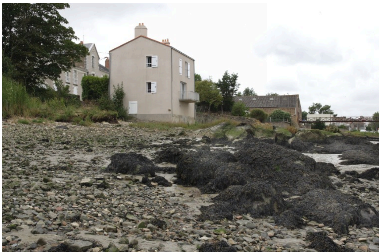
Vue d'ensemble depuis la grève.
