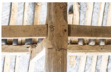
La charpente du pavillon, détail des marques d'assemblage.
