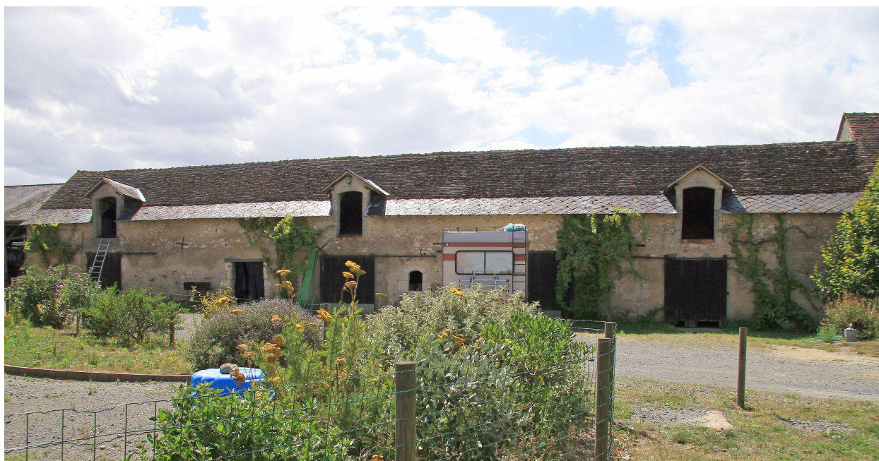
Les étables : façade antérieure sur cour.
