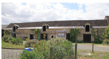
Les étables : façade antérieure sur cour. Phot. Jean-Baptiste Darrasse IVR52_20087201736NUCA
