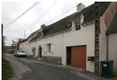
Vue d'ensemble depuis le nord-ouest. Phot. Denis Pillet IVR52_20084400102NUCA
