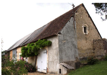
Vue de volume de la grange et des étables. Phot. Jean-Baptiste Darrasse IVR52_20107201112NUCA
