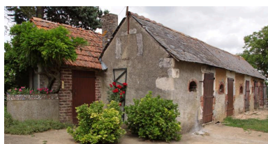
Vue de volume des toits à porcs (XIXe s.). Phot. Jean-Baptiste Darrasse IVR52_20107201113NUCA
