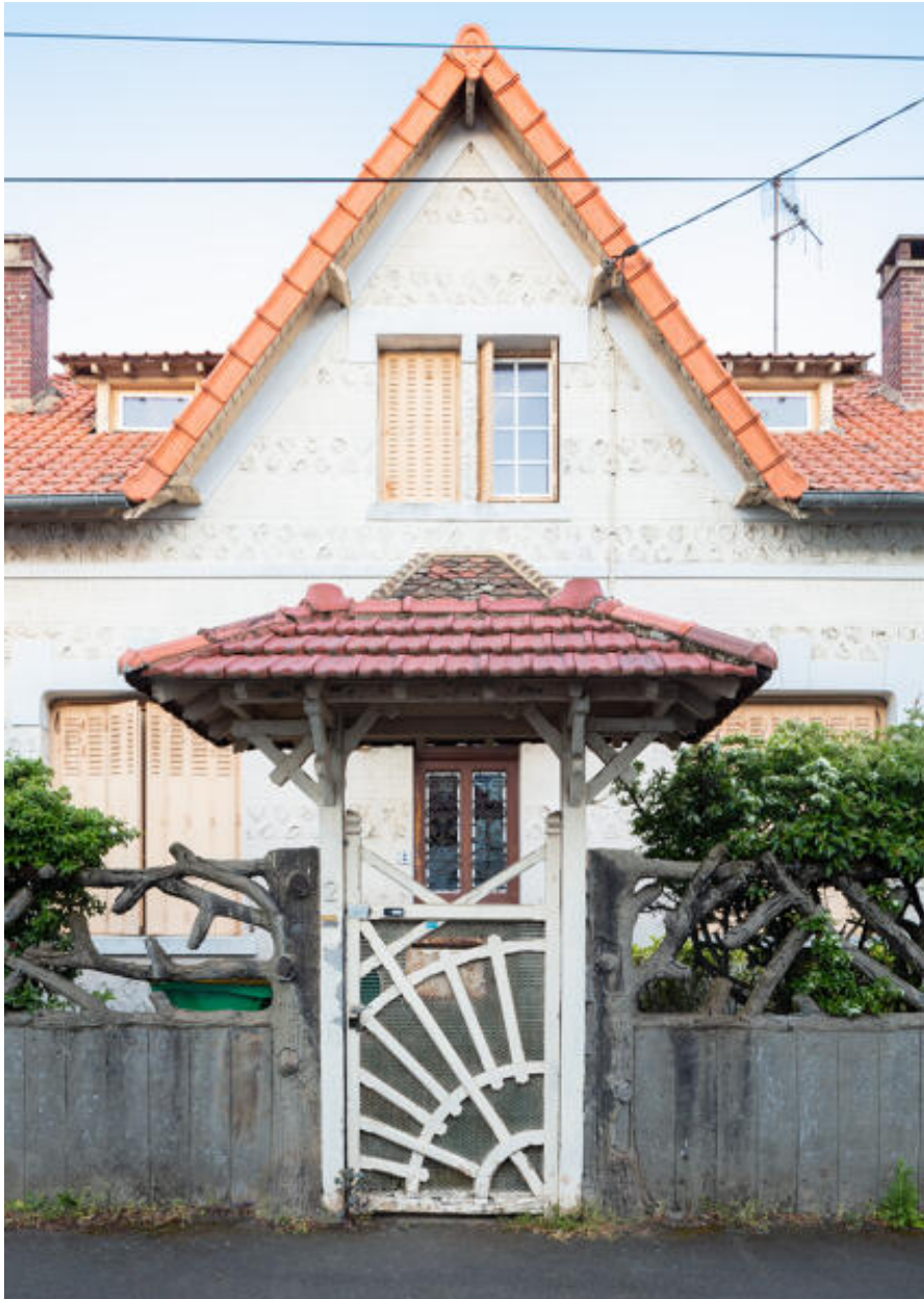
Vue de la travée centrale depuis la rue.
