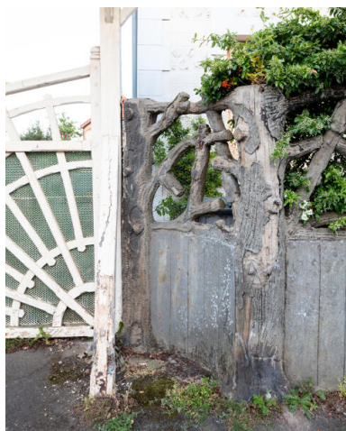
Détail de troncs écotés et portail. Phot. Paul Hamelin IVR52_20227200207NUCA
