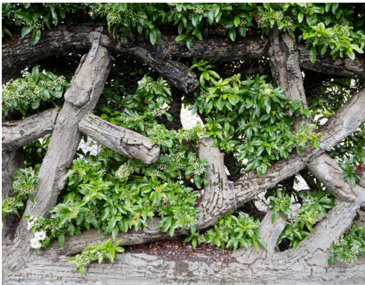
Détail de la partie supérieure de la clôture en tronc écoté.
