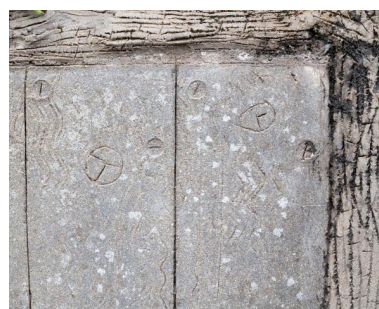
Détail de la partie inférieure de la clôture. Phot. Paul Hamelin IVR52_20227200218NUCA
