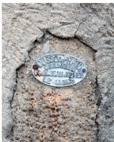
Vue de la plaque d'entrepreneur prise dans le ciment. Phot. Paul Hamelin IVR52_20227200216NUCA
