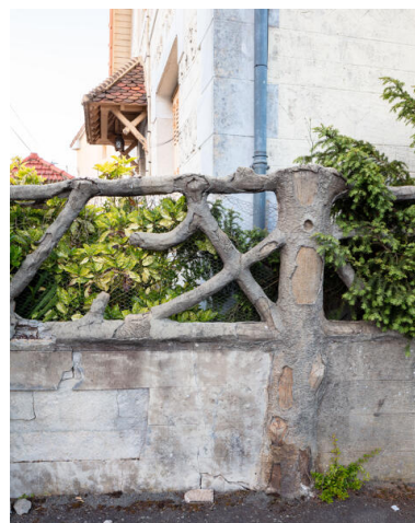
Détail de tronc écoté et parement de clôture au sud. Phot. Paul Hamelin IVR52_20227200205NUCA
