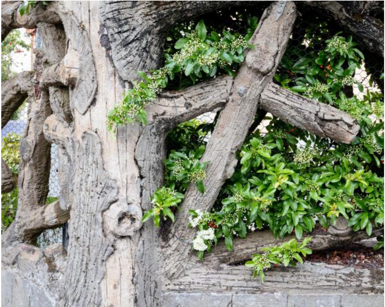
Détail de tronc écoté sur la clôture ouest.
