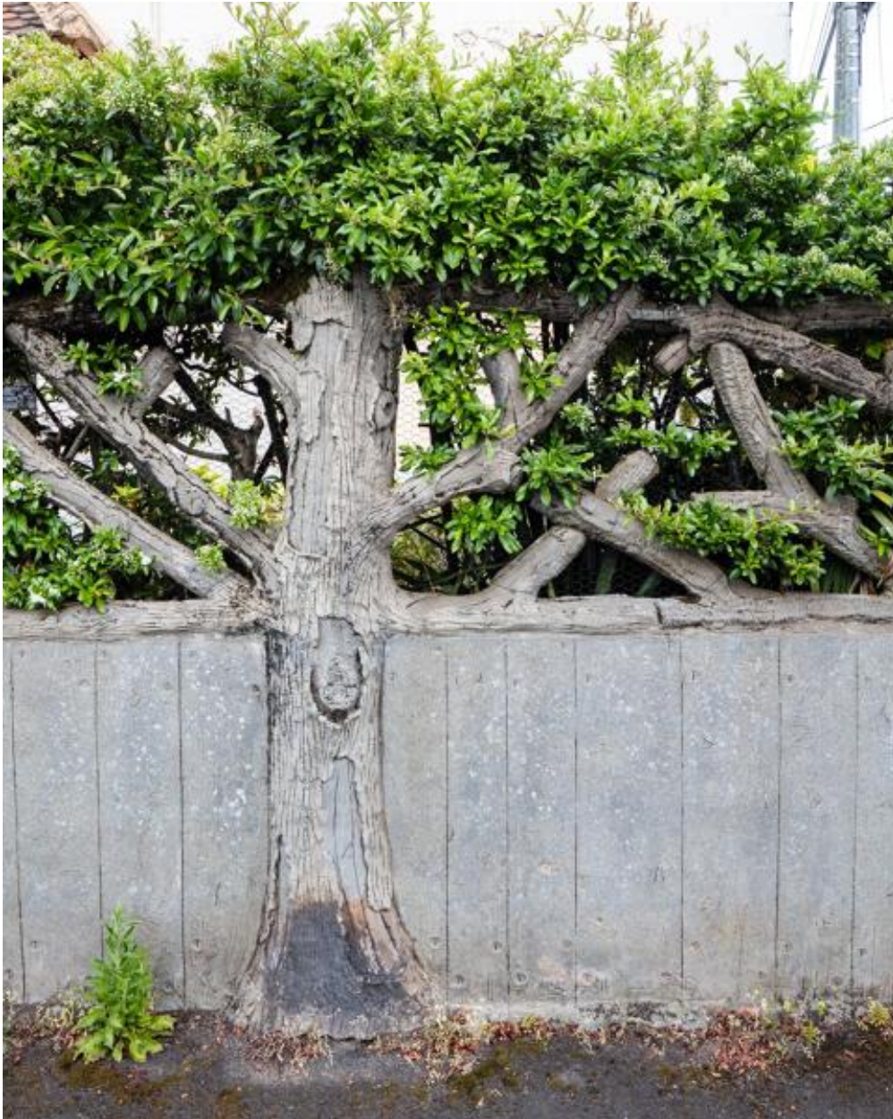
Vue d'un tronc écoté sur la clôture sud.
