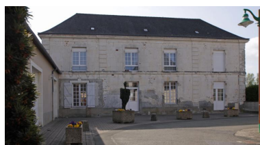
17, rue André Albert. Les Gastinières. Actuellement salle polyvalente. Phot. Jean-Baptiste Darrasse IVR52_20107200798NUCA
