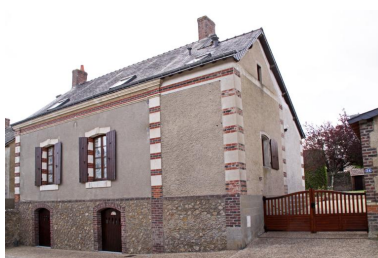
24, rue Frédéric-Chevalier. Phot. Jean-Baptiste Darrasse IVR52_20107200827NUCA
