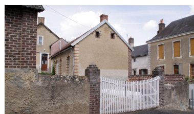
26, rue Frédéric-Chevalier. Phot. Jean-Baptiste Darrasse IVR52_20107200823NUCA
