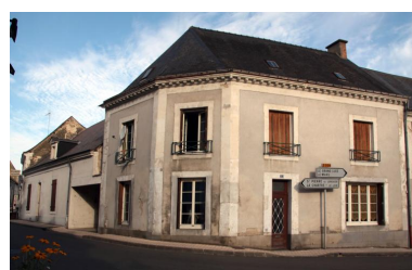
Angle 2, rue Edmond-Charlot et 8, rue Max-Cochard. Phot. Jean-Baptiste Darrasse IVR52_20107201308NUCA
