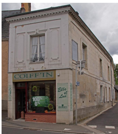
7, rue Max-Cochard. Phot. Jean-Baptiste Darrasse IVR52_20107201132NUCA
