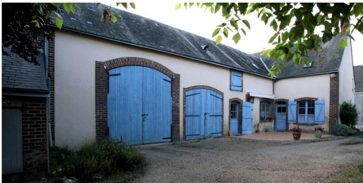
10, rue Edmond-Charlot : cour intérieure de la ferme.
