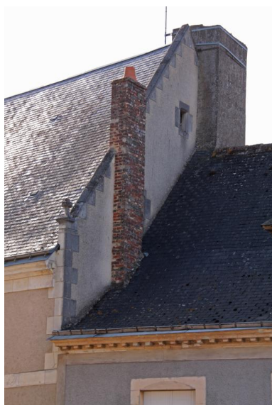
Pignon du 2, rue Frédéric-Chevalier. Phot. Jean-Baptiste Darrasse IVR52_20107201461NUCA
