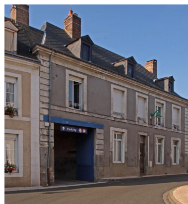
11, place du 8 mai 1945. Phot. Jean-Baptiste Darrasse IVR52_20107201167NUCA
