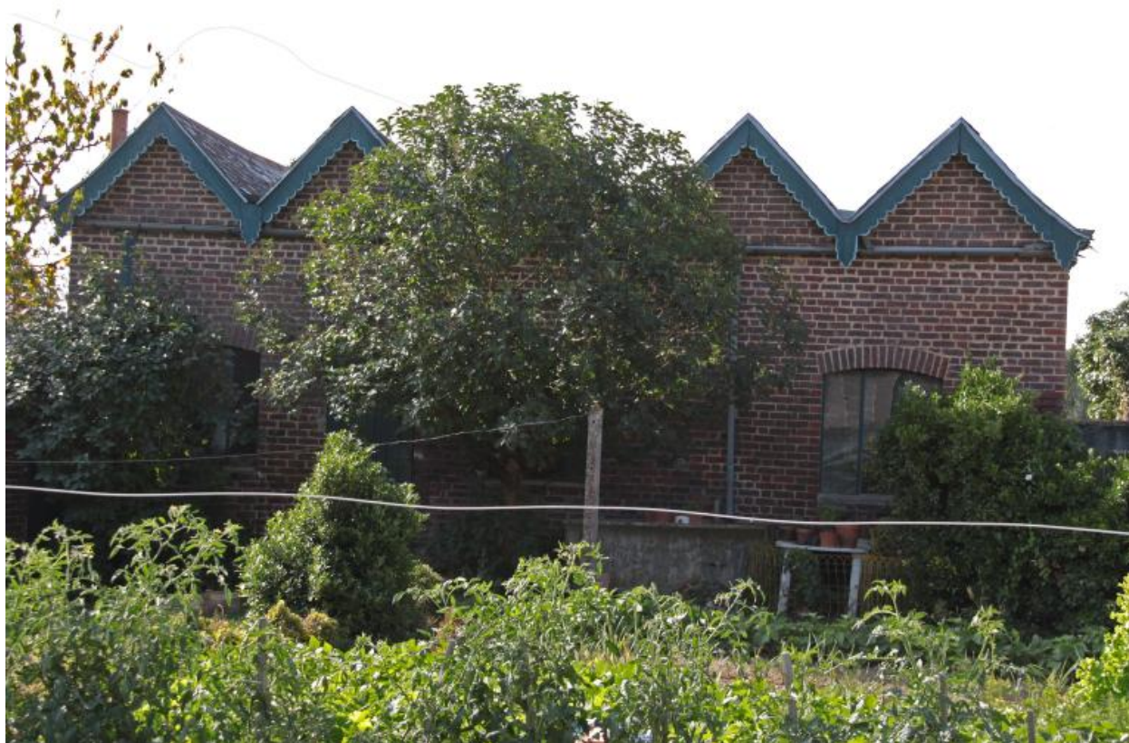
15, rue Edmond-Charlot. Sheds en fond de cour.
