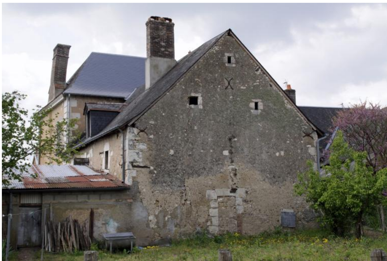
15, rue Frédéric-Chevalier : mur pignon de la seconde maison.
