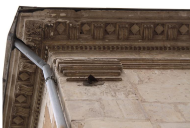
6, rue Frédéric-Chevalier : détail du décor de la façade sur rue. Phot. Jean-Baptiste Darrasse IVR52_20107201127NUCA
