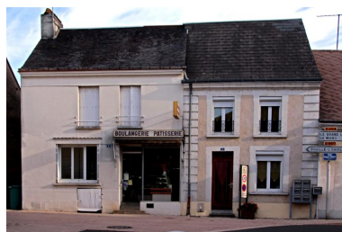
4 et 6, rue Edmond-Charlot. Phot. Jean-Baptiste Darrasse IVR52_20107201310NUCA
