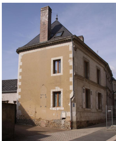
6, rue Frédéric-Chevalier. Phot. Jean-Baptiste Darrasse IVR52_20107200804NUCA
