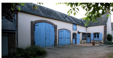
10, rue Edmond-Charlot : cour intérieure de la ferme. Phot. Jean-Baptiste Darrasse IVR52_20107201314NUCA
