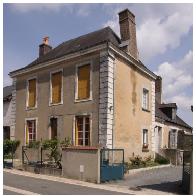
15, rue Frédéric-Chevalier. Phot. Jean-Baptiste Darrasse IVR52_20107200821NUCA
