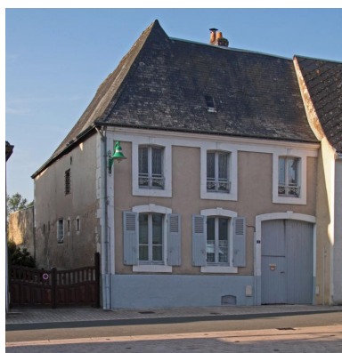
5, place du 8 mai 1945. Phot. Jean-Baptiste Darrasse IVR52_20107201166NUCA
