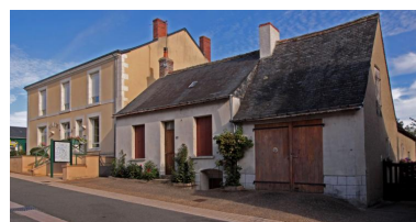
18 et 20-22, rue Edmond-Charlot. Phot. Jean-Baptiste Darrasse IVR52_20107201317NUCA
