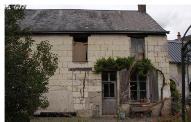
8, rue Frédéric-Chevalier. Phot. Jean-Baptiste Darrasse IVR52_20107201126NUCA
