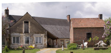
9 et 11, rue Frédéric-Chevalier : cour intérieure. Phot. Jean-Baptiste Darrasse IVR52_20107200830NUCA
