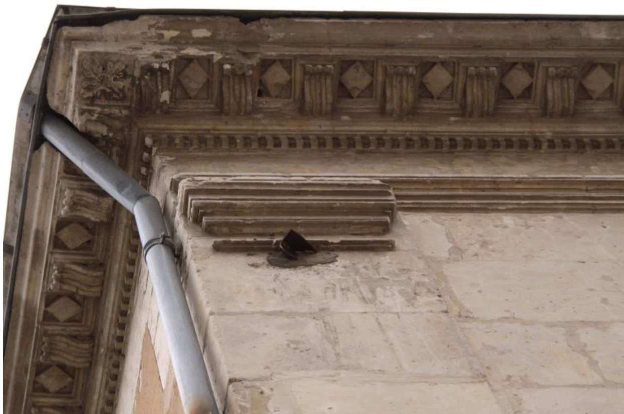
6, rue Frédéric-Chevalier : détail du décor de la façade sur rue.
