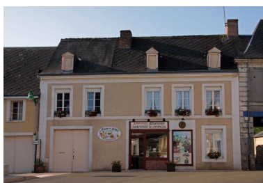
9, place du 8 mai 1945. Phot. Jean-Baptiste Darrasse IVR52_20107201168NUCA
