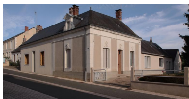
14 et 16, rue Edmond-Charlot. Phot. Jean-Baptiste Darrasse IVR52_20107201315NUCA
