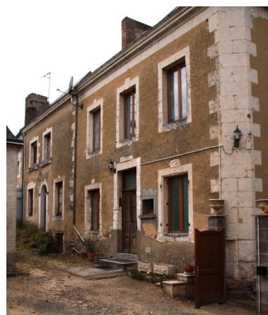
4 et 6, rue Frédéric- Chevalier : façades sur cour. Phot. Jean-Baptiste Darrasse IVR52_20107201124NUCA
