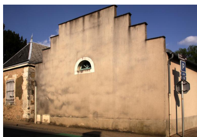
17, rue André Albert. Actuellement salle polyvalente. Phot. Jean-Baptiste Darrasse IVR52_20107201014NUCA
