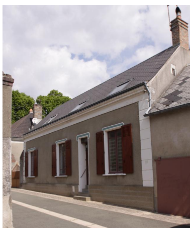
7, rue Frédéric-Chevalier. Phot. Jean-Baptiste Darrasse IVR52_20107200818NUCA
