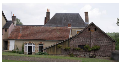
26, rue Frédéric-Chevalier : cour intérieure. Phot. Jean-Baptiste Darrasse IVR52_20107200824NUCA
