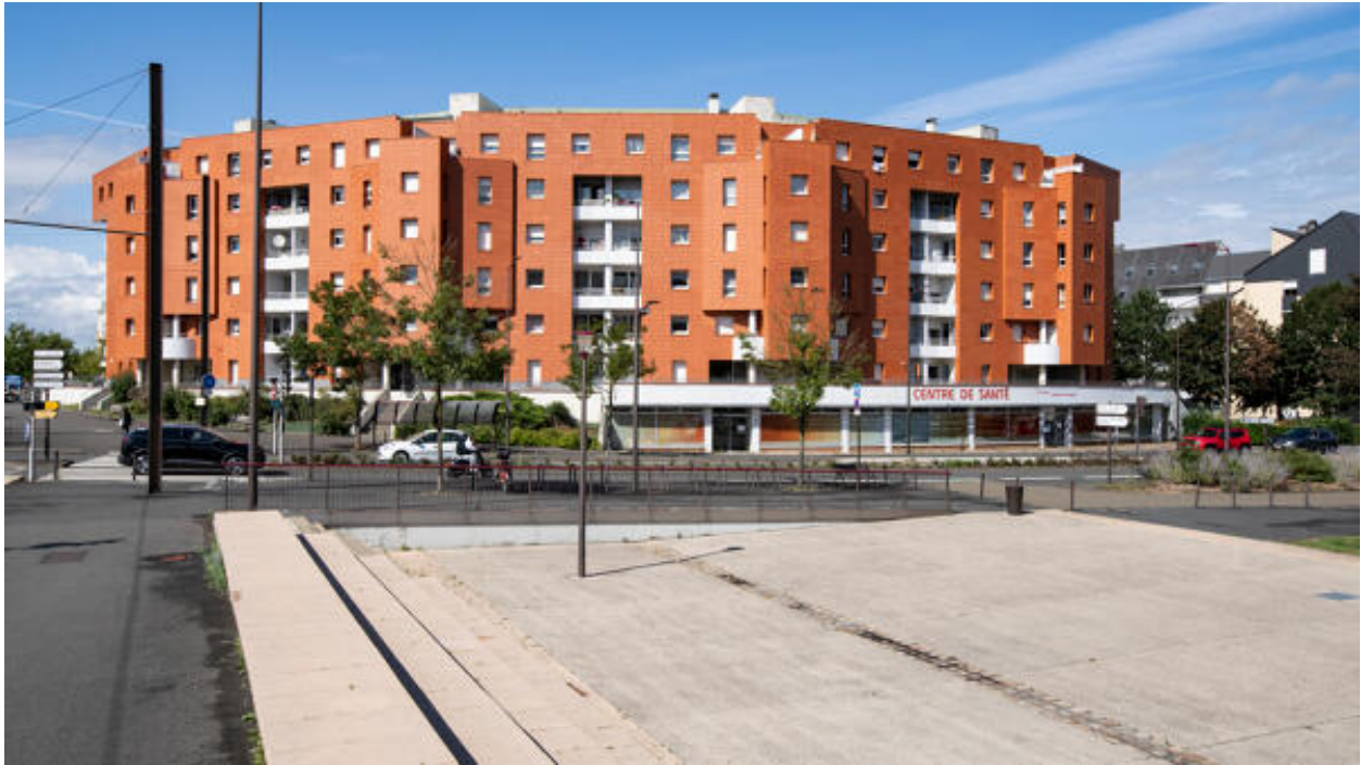
Vue de l'immeuble accueillant en rez-de-chaussée la mairie annexe de Pontlieue.
