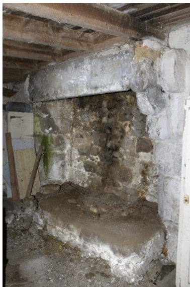
Vue de la cheminée est. Phot. Denis Pillet IVR52_20074401631NUCA
