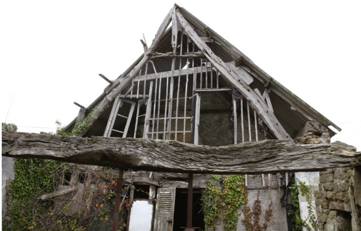
Détail de la charpente du logis est.
