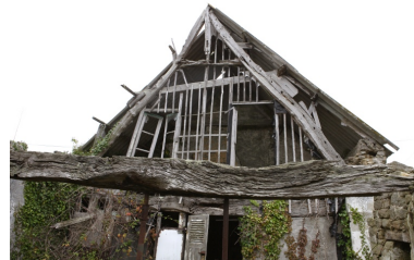
Détail de la charpente du logis est. Phot. Denis Pillet IVR52_20074401638NUCA
