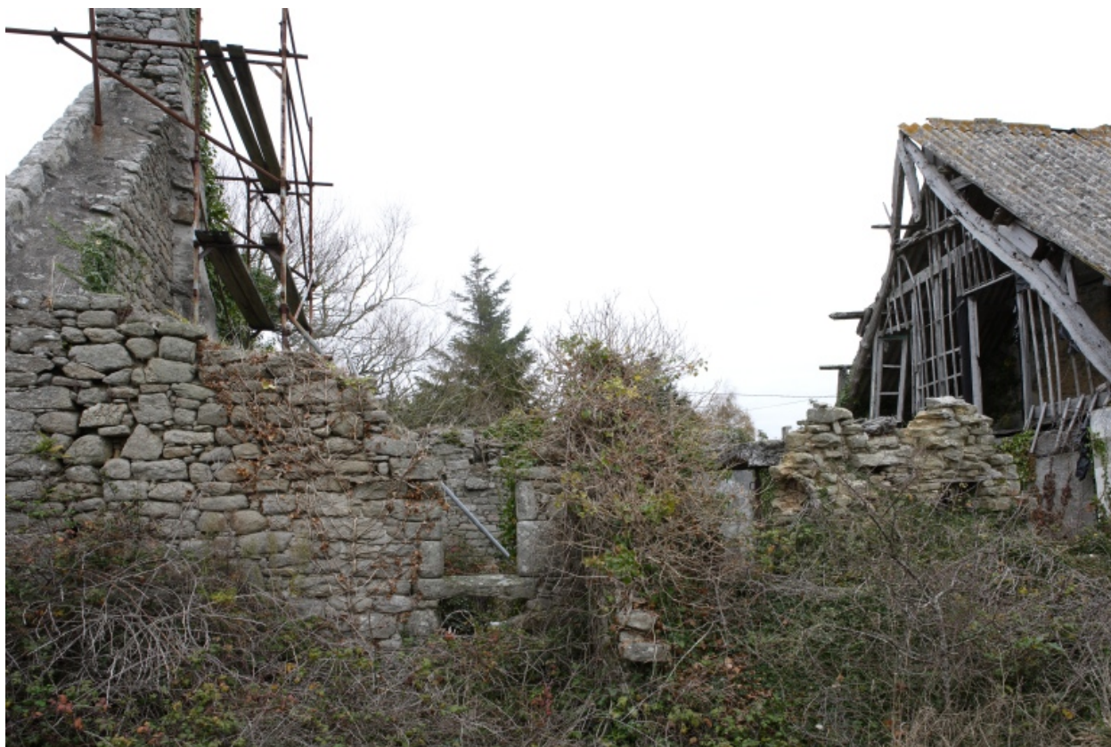
Vue du mur gouttereau sud.
