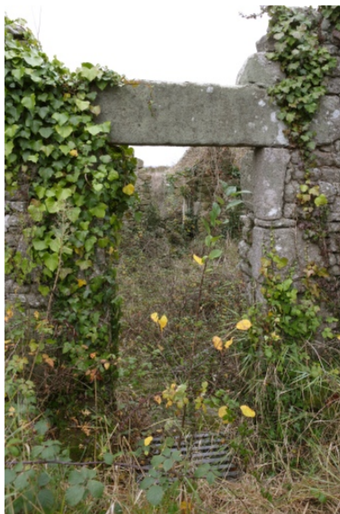
Détail de la porte nord. Phot. Denis Pillet IVR52_20074401639NUCA
