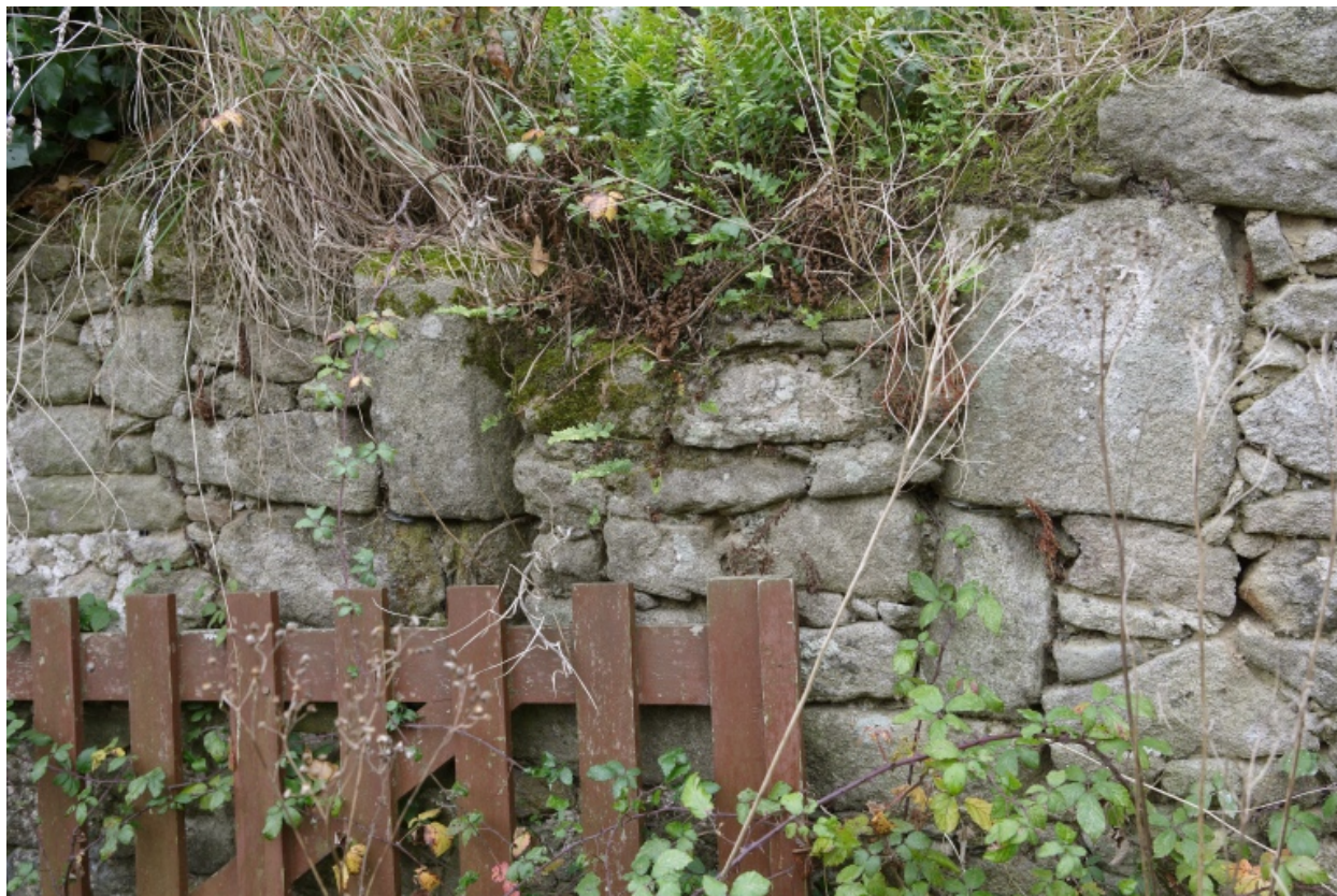
Détail d'une fenêtre bouché sur le mur nord.
