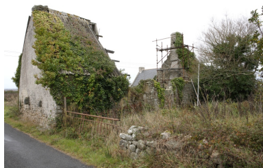
Vue depuis le nord est. Phot. Denis Pillet IVR52_20074401644NUCA
