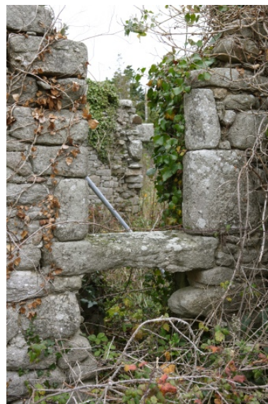
Détail de la baie sud. Phot. Denis Pillet IVR52_20074401642NUCA
