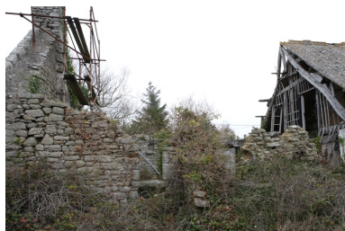
Vue du mur gouttereau sud. Phot. Denis Pillet IVR52_20074401641NUCA
