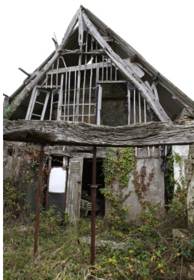
Vue du pignon est. Phot. Denis Pillet IVR52_20074401637NUCA
