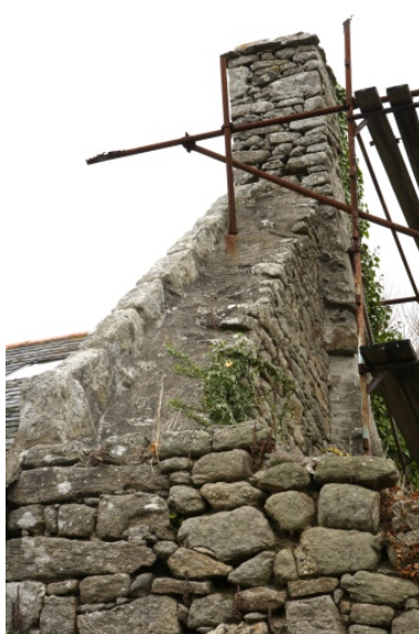
Détail du pignon découvert ouest. Phot. Denis Pillet IVR52_20074401643NUCA
