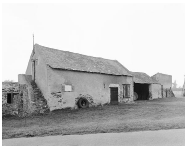
Bâtiments d'exploitation au sud-ouest de la cour, 1985. Phot. Bruno Rousseau IVR52_19854901824V
