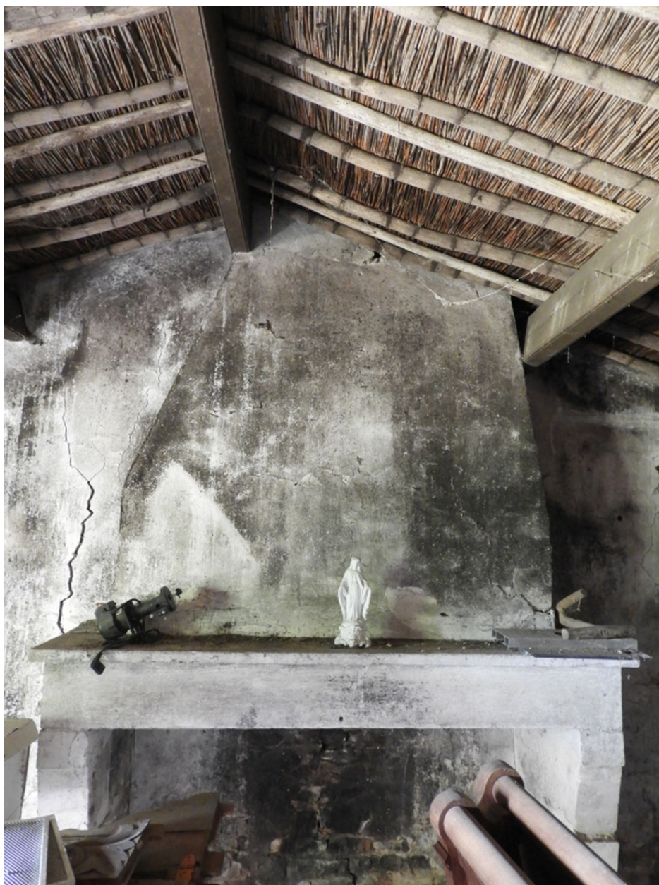
Cheminée et toit en roseau à l'intérieur du logis (pièce à gauche). Les murs sont noircis par l'activité viticole.
