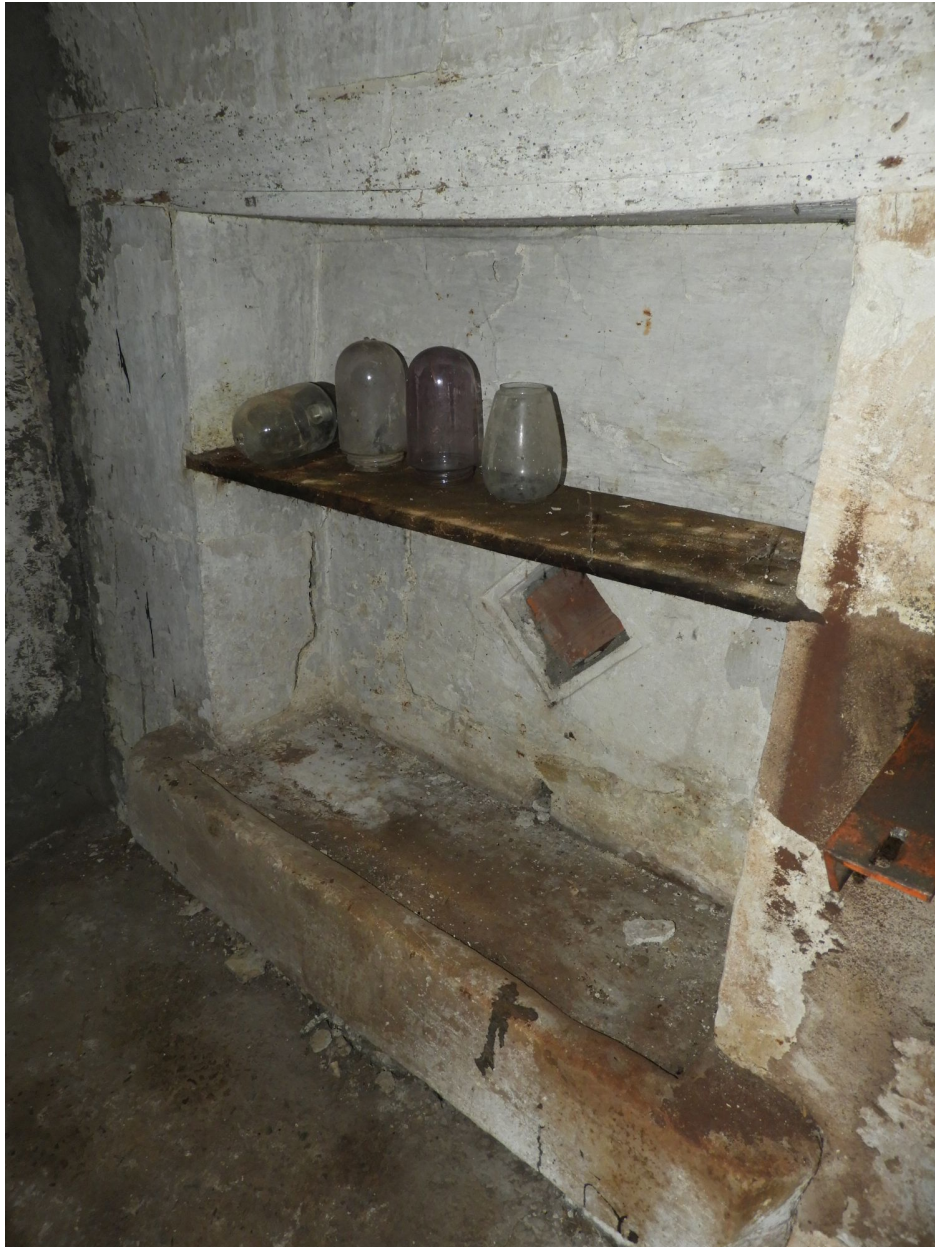
Placard aménagé dans l'épaisseur d'un mur.
