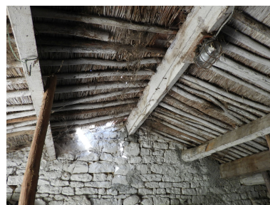
Toit en roseau à l'intérieur du logis. Phot. Yannis Suire IVR52_20198500115NUCA
