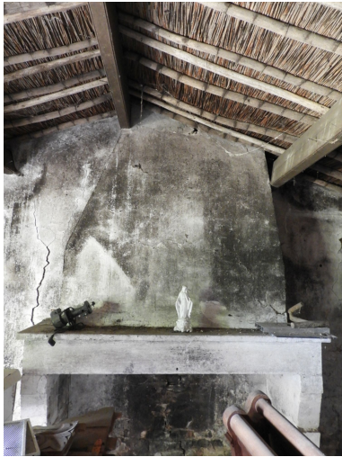
Cheminée et toit en roseau à l'intérieur du logis (pièce à gauche). Les murs sont noircis par l'activité viticole. Phot. Yannis Suire IVR52_20198500119NUCA
