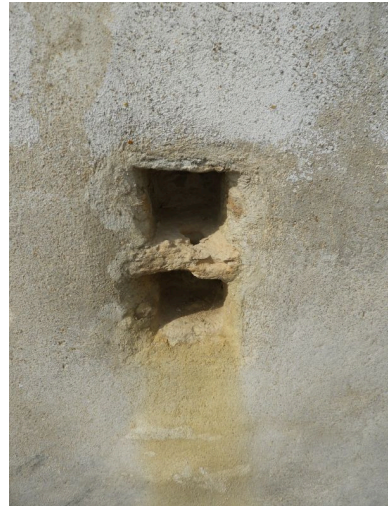
Anneau d'attache pour animaux aménagé dans le mur pignon est de la dépendance. Phot. Yannis Suire IVR52_20188500453NUCA
