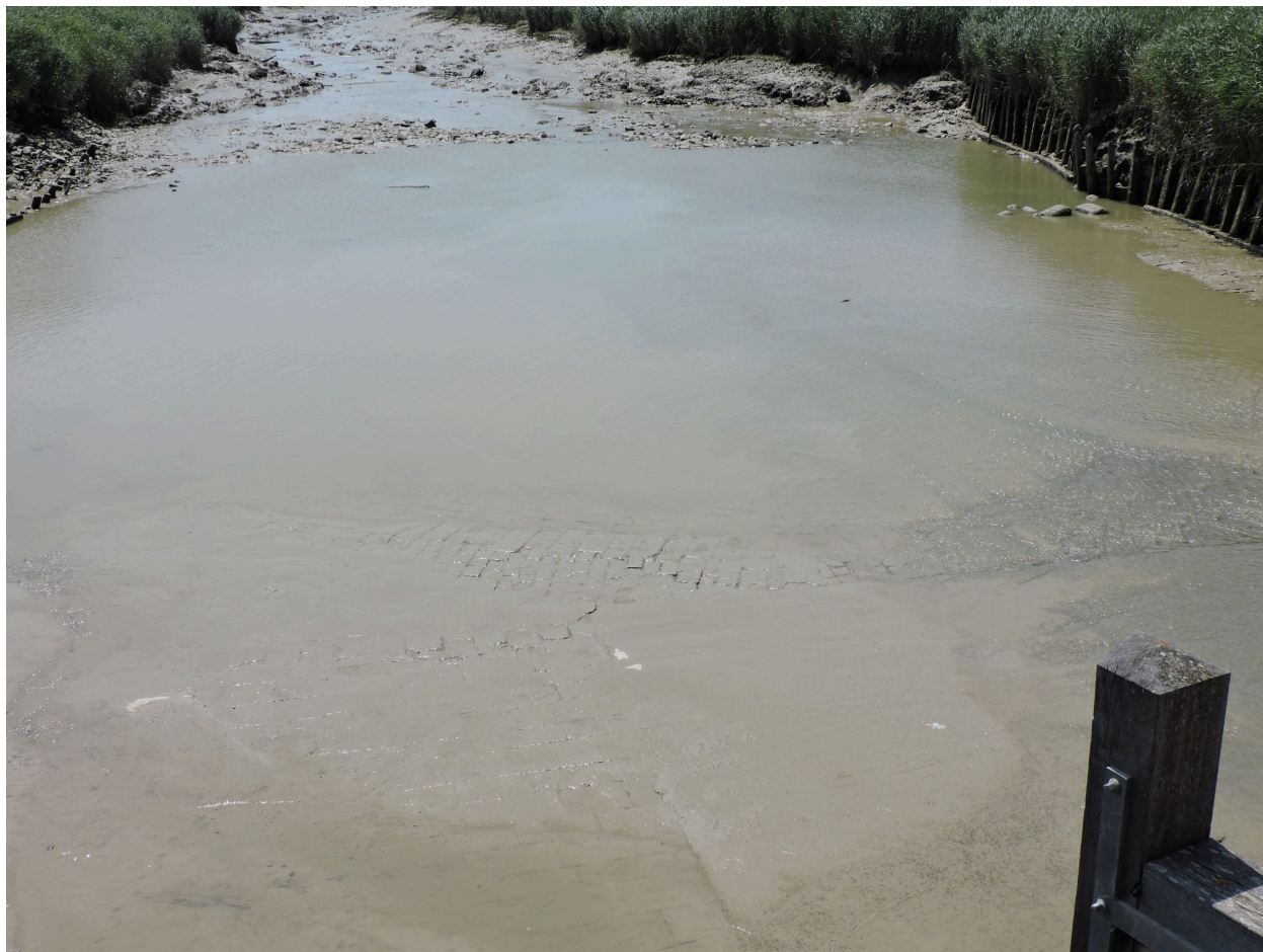
Le radier en pierre affleurant dans le chenal en aval des portes, à marée basse.
