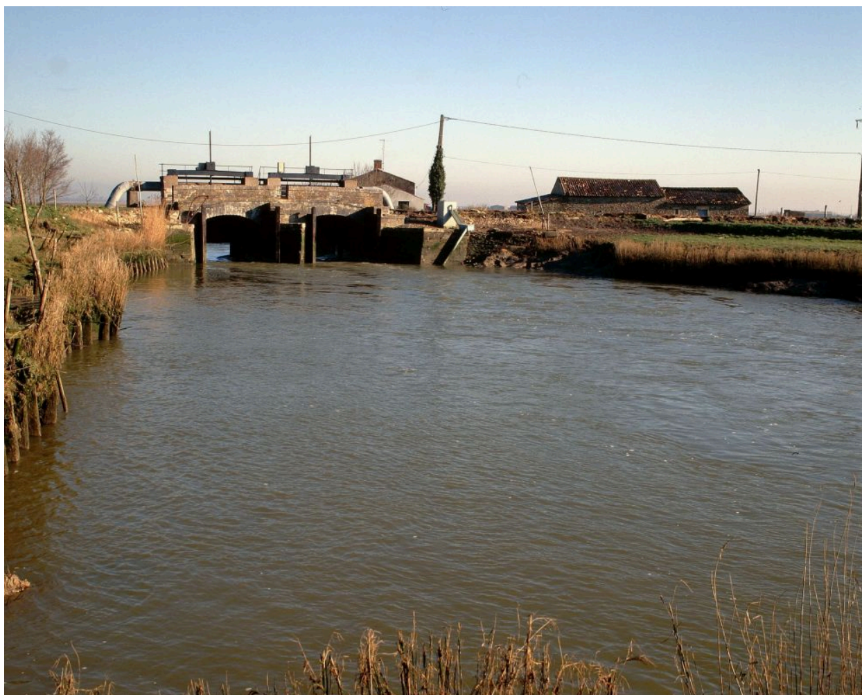
Les portes vues depuis l'aval.
