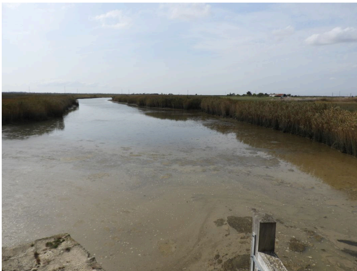
Le chenal en aval des portes.
