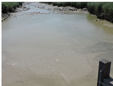
Le radier en pierre affleurant dans le chenal en aval des portes, à marée basse. Phot. Yannis Suire IVR52_20218500001NUCA
