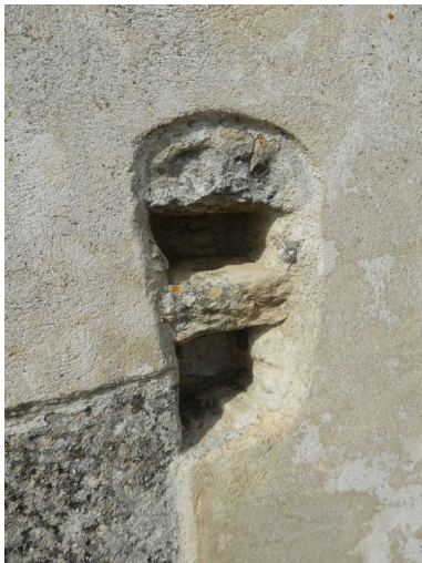
Anneau d'attache pour animaux aménagé dans le mur pignon est de la dépendance. Phot. Yannis Suire IVR52_20188500454NUCA
