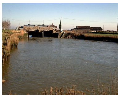
Les portes vues depuis l'aval. Phot. Christophe Yvernogeu IVR52_20008500054XA
