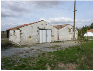
Dépendances (ancienne grange-étable ?) vues depuis le sud-est. Phot. Yannis Suire IVR52_20188500443NUCA
