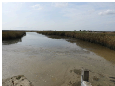
Le chenal en aval des portes. Phot. Yannis Suire IVR52_20188500448NUCA
