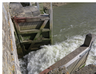
Les battants ouverts de la porte ouest, laissant l'eau s'évacuer. Phot. Yannis Suire IVR52_20188501078NUCA
