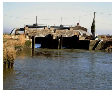
Les portes vues depuis l'aval. Phot. Christophe Yvernogeu IVR52_20008500055XA
