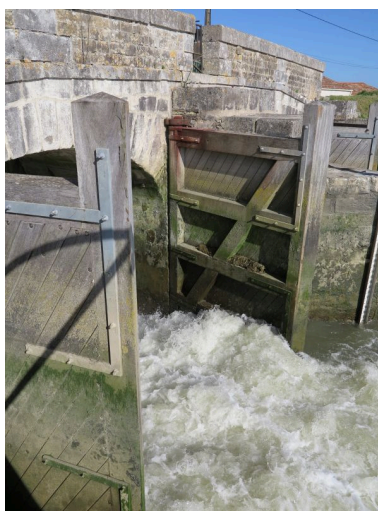
La sortie côté aval du pertuis de la porte ouest. l'eau s'évacuant à travers la porte ouverte. Phot. Yannis Suire IVR52_20188501073NUCA
