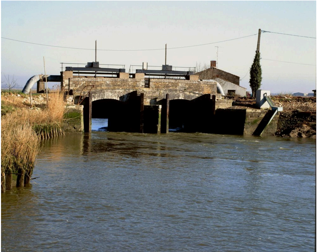
Les portes vues depuis l'aval.
