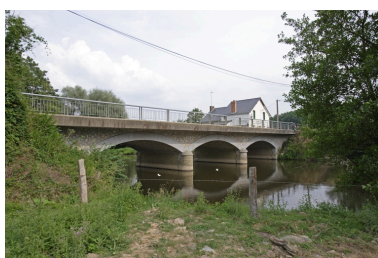
Vue d'ensemble depuis la rive gauche en amont. Phot. François Lasa
