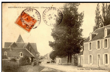
Vue de la maison de maître dans le 1er quart du XXe siècle Autr. B. Aveline IVR52_20137200006NUCA
