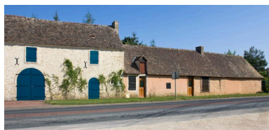
Vue partielle : communs, logement et parties agricoles Phot. Patrice Giraud IVR52_20117200569NUCA
