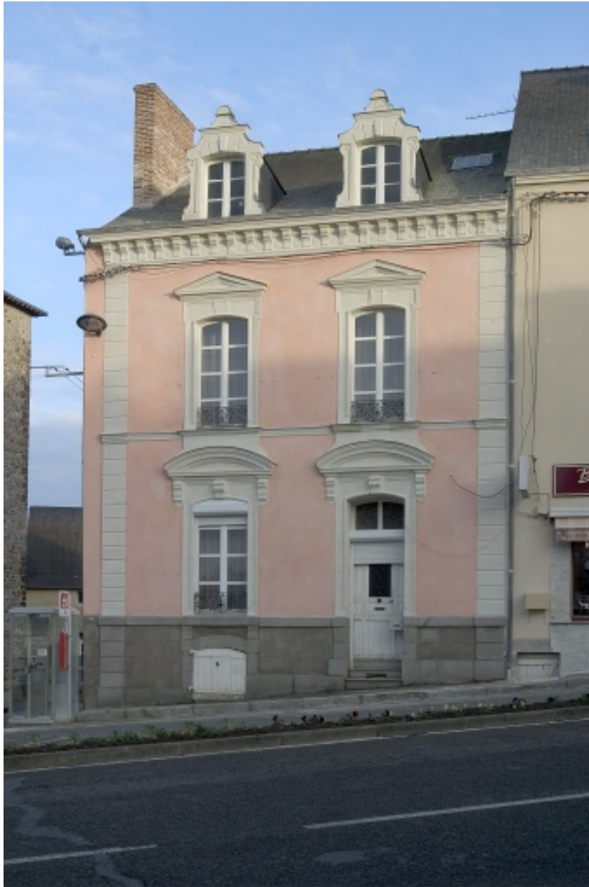
Vue de la façade principale, en cours de ravalement, depuis la place.
