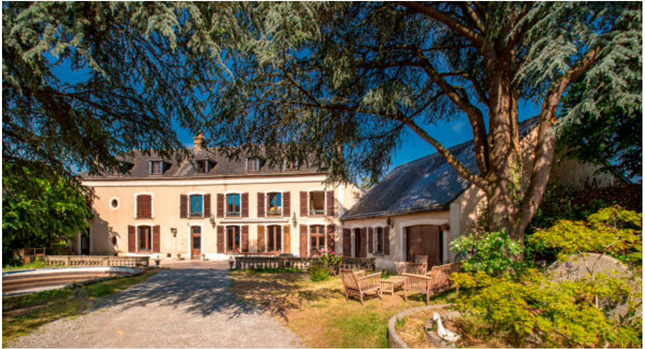
Façade orientale du corps de logis nord-sud.
