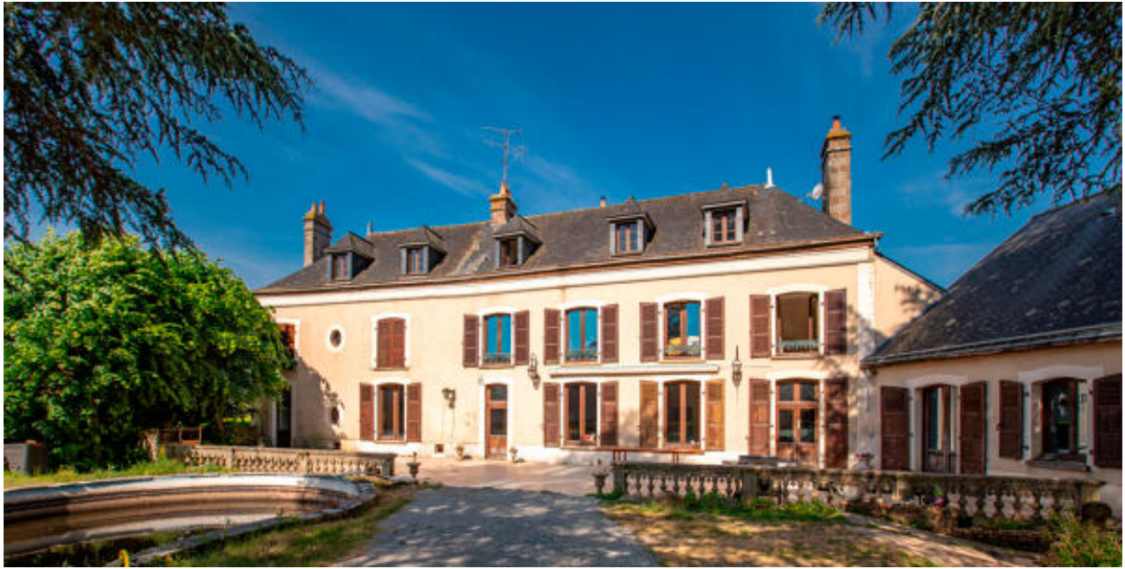
Façade orientale du corps de logis nord-sud.
