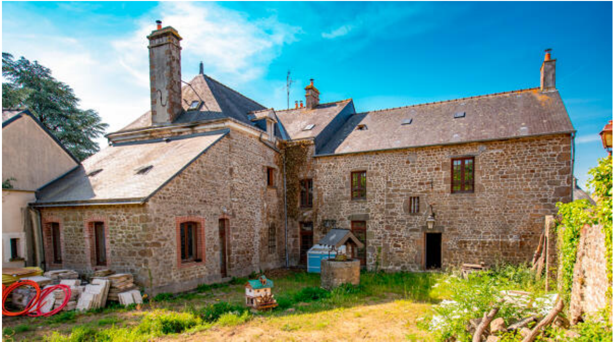
Maison du 9 rue de Javron vue depuis le nord-ouest.
