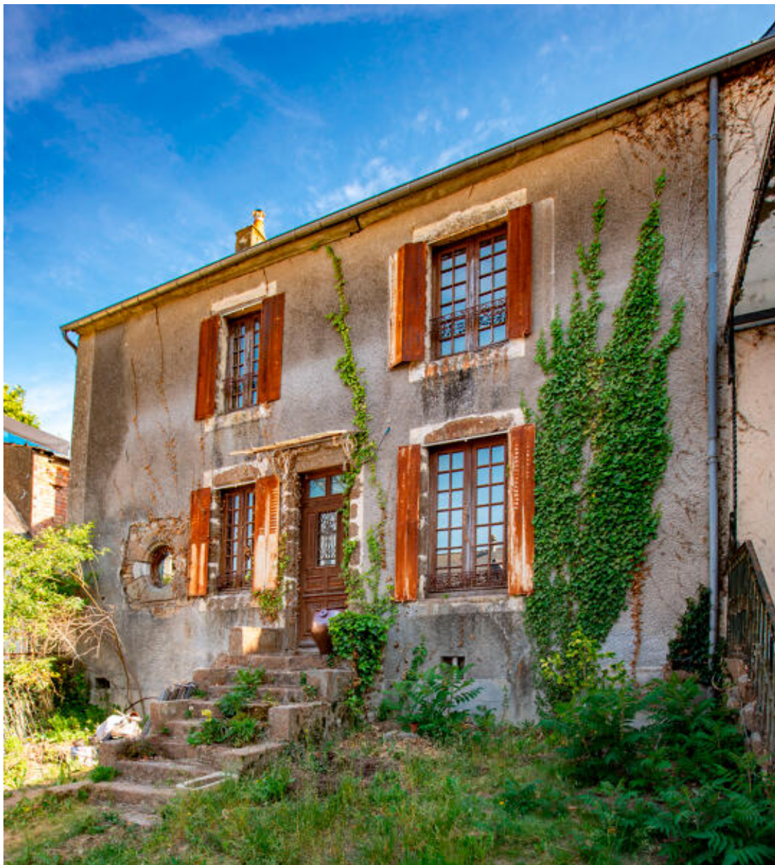
Façade sud du corps de logis est-ouest ; linteau à accolade.
