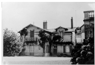
Dépendances à l'est du bâtiment principal. Photographie, [s.d.]. Repro. Denis Pillet IVR52_19964401122X
