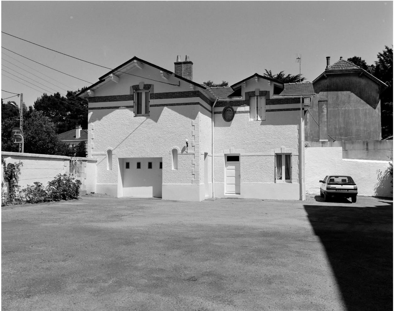
Dépendances à l'est du bâtiment principal.
