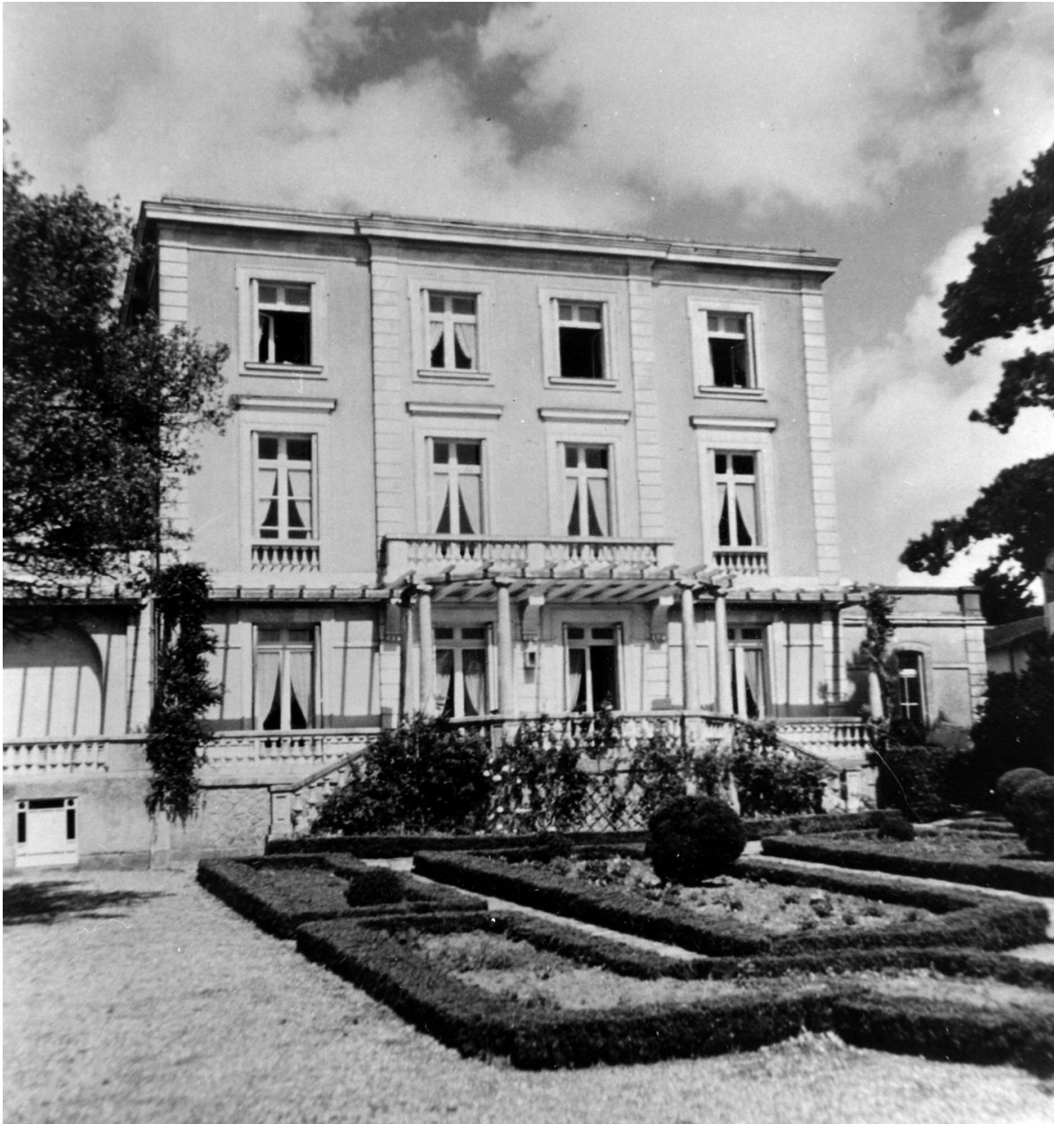
Elévation sud. Photographie, [s.d.].
