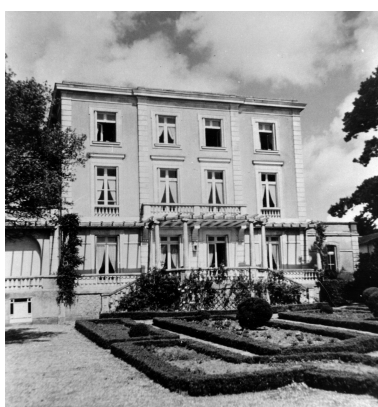
Elévation sud. Photographie, [s.d.].
