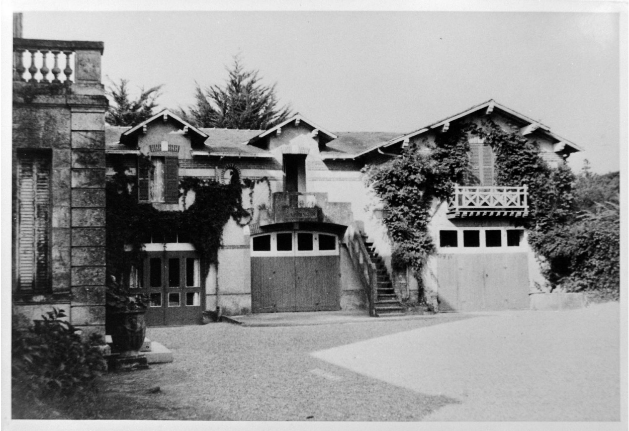
Dépendances à l'ouest du bâtiment principal. Photographie, [s.d.].
