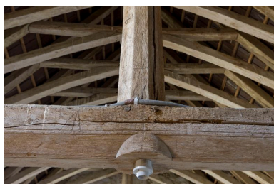
Chapelle, charpente : détail. Phot. Denis Pillet IVR52_20117200020NUCA
