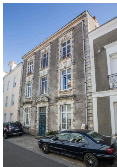
Maison, 24 rue Aristide-Bertreux. IVR52_20184400350NUCA
