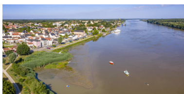
Vue du bourg du Pellerin vers l'aval depuis le site Bikini. Phot. Pierre-Bernard Fourny IVR52_20214400604NUCA
