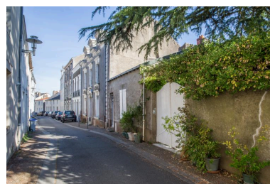
Vue de la rue Aristide- Bertreux, vers l'ouest. Phot. Pierre-Bernard Fourny IVR52_20184400351NUCA
