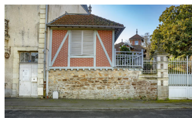
Pavillon de jardin, quai du Docteur-André-Provost. Phot. Pierre-Bernard Fourny IVR52_20224400013NUCA
