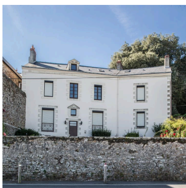
Maison, 5 rue du Verger. Phot. Pierre-Bernard Fourny IVR52_20184400369NUCA
