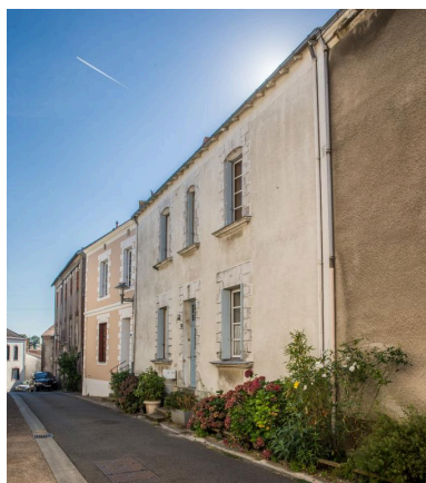
Maison, 57 rue Aristide-Bertreux. IVR52_20184400355NUCA
