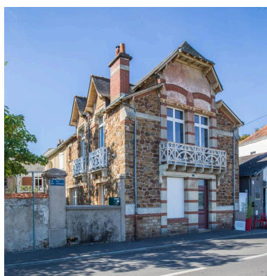
Miaosn, 1 quai des Coteaux. Phot. Pierre-Bernard Fourny IVR52_20184400364NUCA
