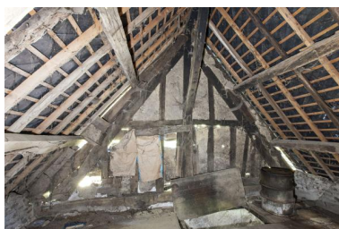
Pignon nord du logis nord. Phot. Yves Guillotin IVR52_20185300393NUCA
