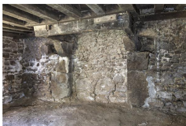
Cheminée du logis-étable sud.
