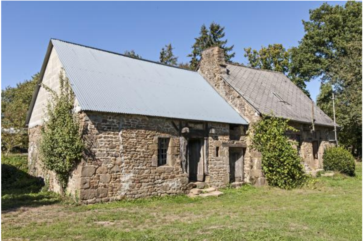
Maison vue depuis le sud-est.
