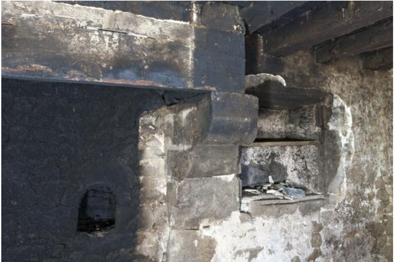
Logis nord, cheminée.
