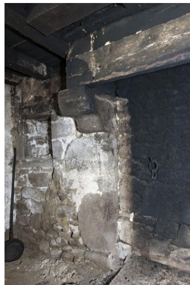
Logis nord, piédroit gauche de la cheminée. Phot. Yves Guillotin IVR52_20185300390NUCA
