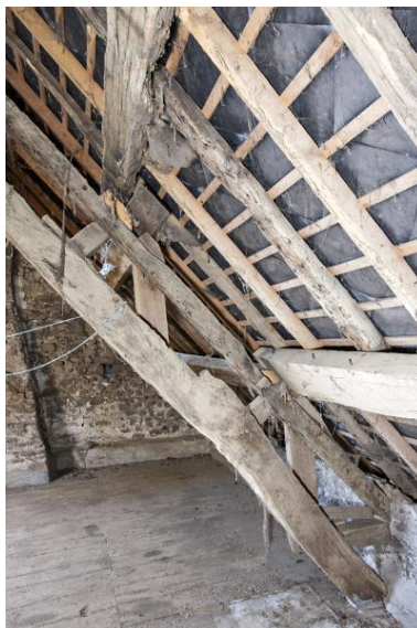
Charpente du logis nord. Phot. Yves Guillotin IVR52_20185300392NUCA
