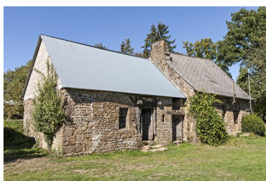
Maison vue depuis le sud-est.
