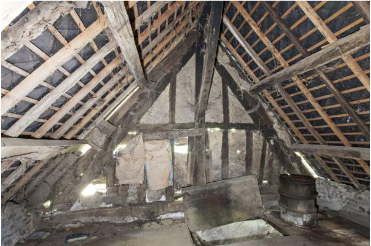
Pignon nord du logis nord.
