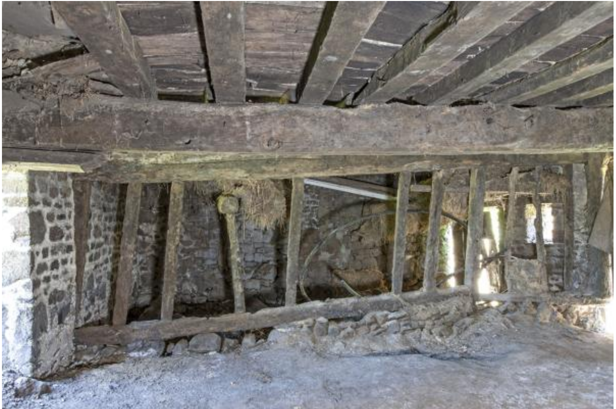
Cloison séparant l'étable du logis sud.
