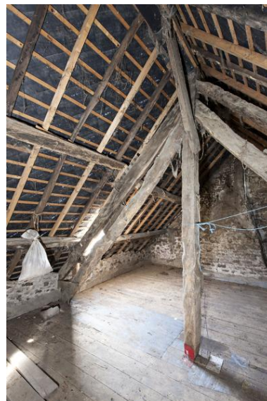
Charpente du logis nord. Phot. Yves Guillotin IVR52_20185300391NUCA
