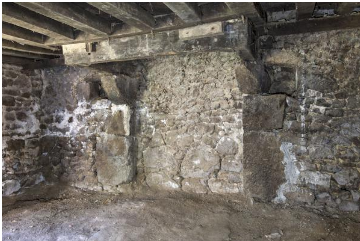
Cheminée du logis-étable sud.
