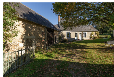
Ferme ouest : vue sur la cour avec grange-étable au premier plan et logis à l'arrière-plan. Phot. Jeanne Minier IVR52_20257200645NUCA
