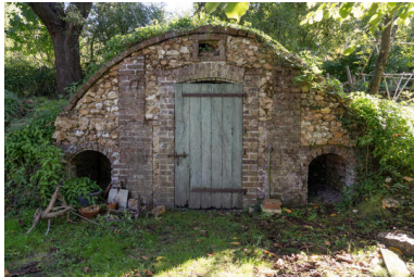
Ferme est : buanderie. Phot. Jeanne Minier IVR52_20257200650NUCA
