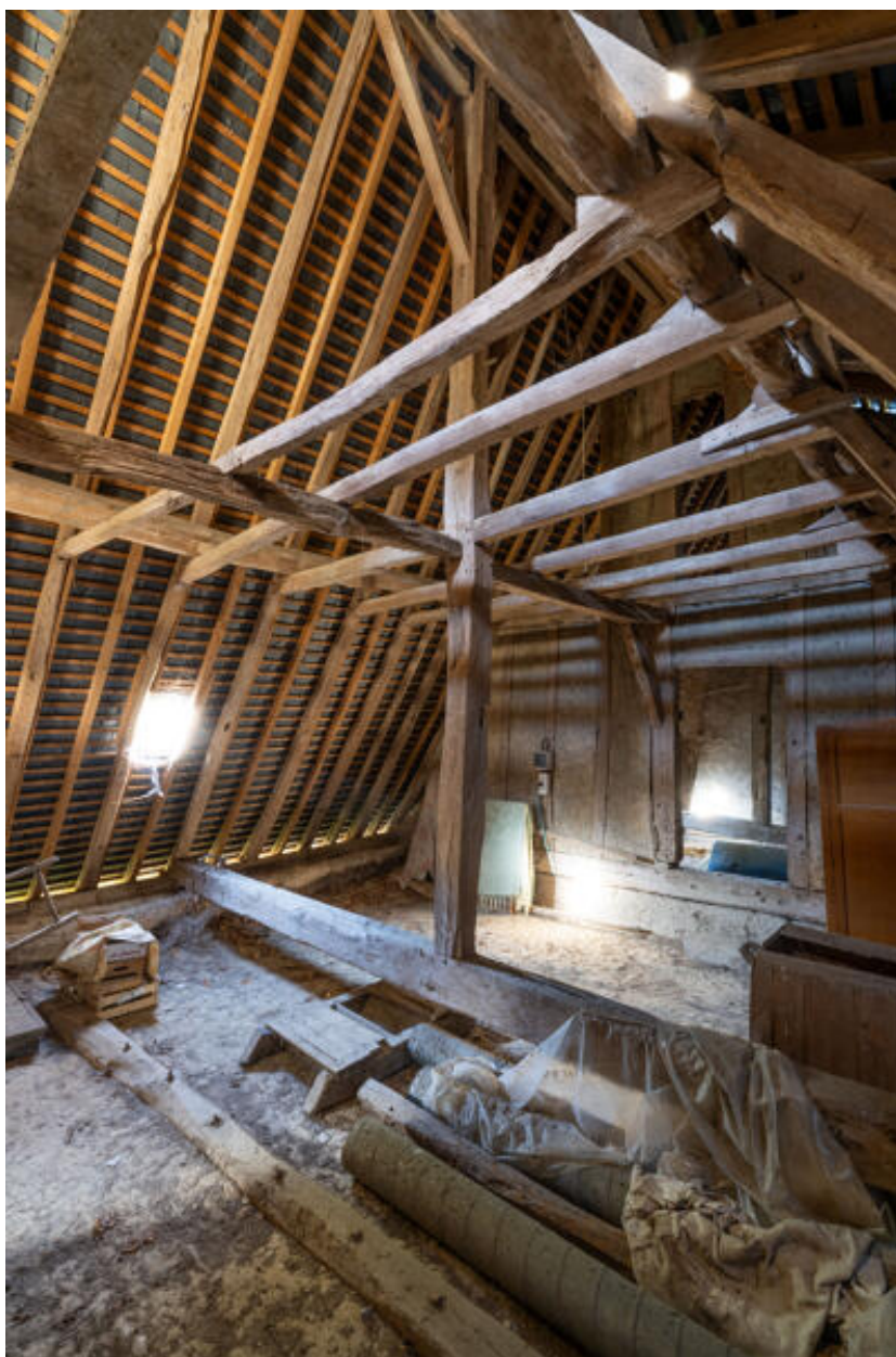
Ferme ouest : charpente du logis.
