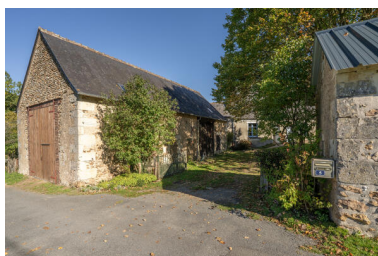
Ferme ouest : entrée de la cour. Phot. Jeanne Minier IVR52_20257200644NUCA
