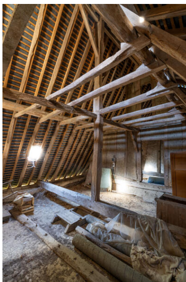
Ferme ouest : charpente du logis. Phot. Jeanne Minier IVR52_20257200647NUCA
