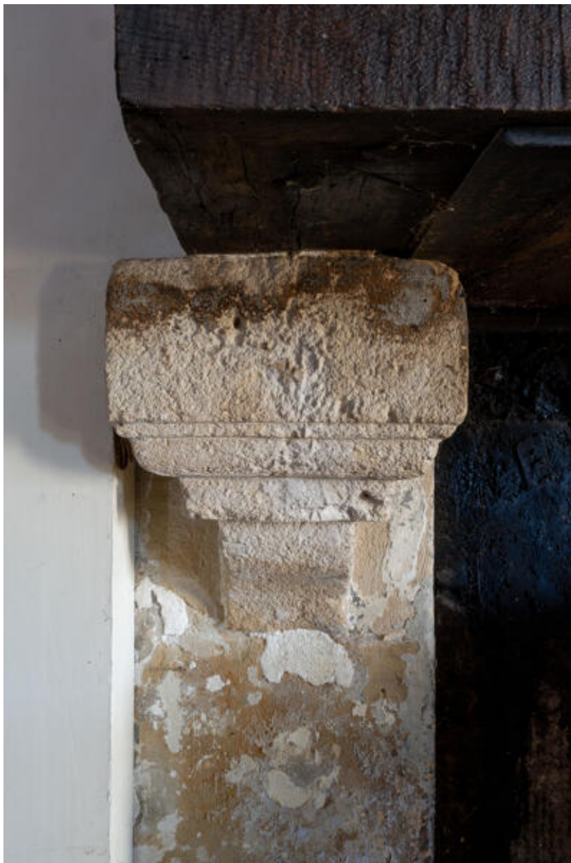
Ferme est, logis, cheminée : détail de console.
