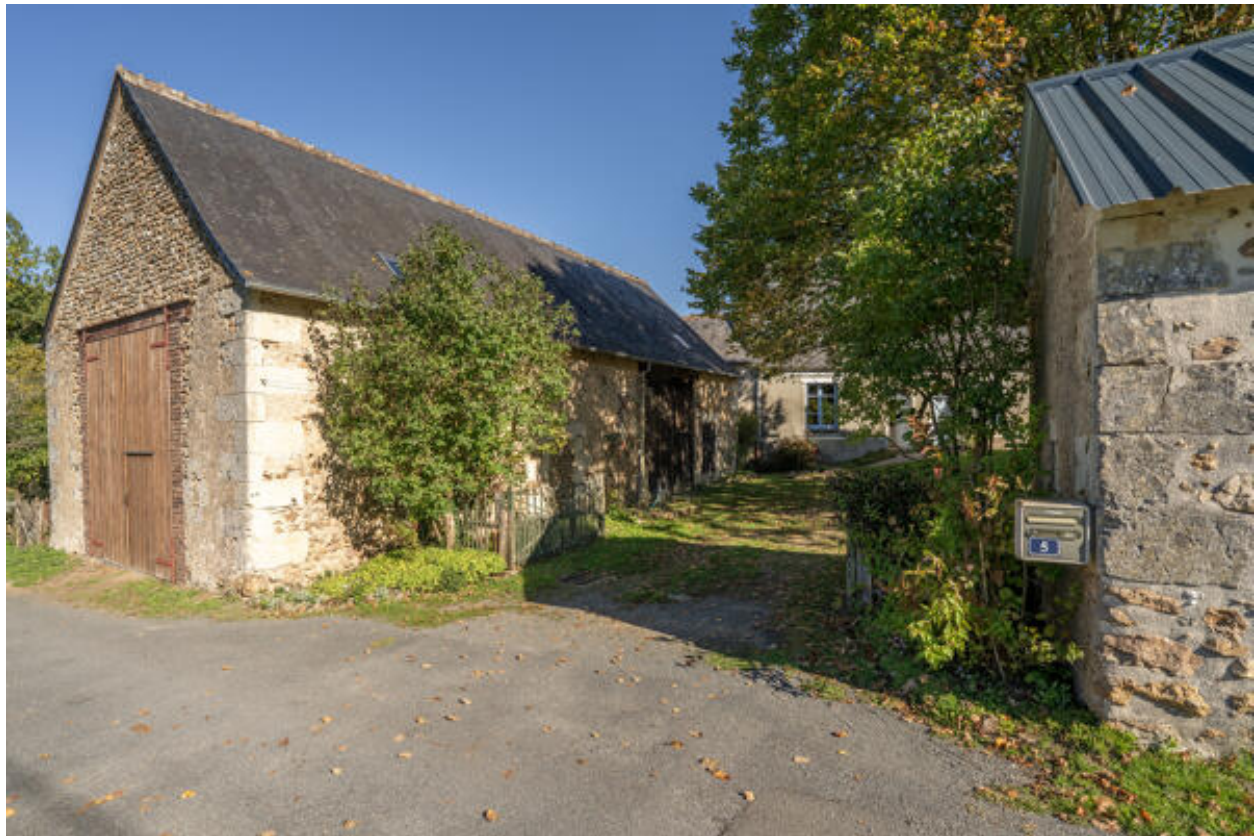
Ferme ouest : entrée de la cour.
