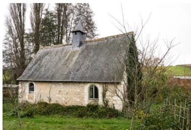
Flanc sud. Phot. Thierry Seldubuisson IVR52_20237202028NUCA
