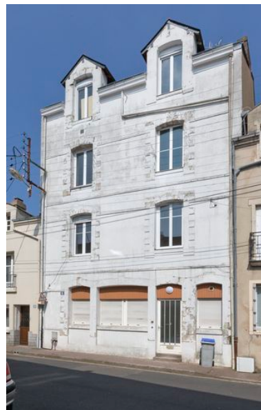
Immeuble, 6, rue de Tréméac. Phot. Denis Pillet IVR52_20134401419NUCA
