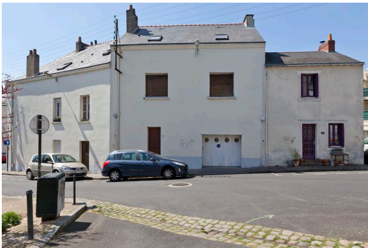
Ilot, vue du nord.
