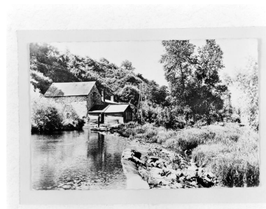
Le moulin vu du nord, en amont. Repro. François Lasa IVR52_20025301173X
