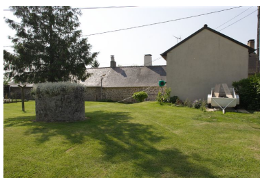
Le bâtiment principal vu depuis le nord. Phot. François Lasa IVR52_20055301688NUCA
