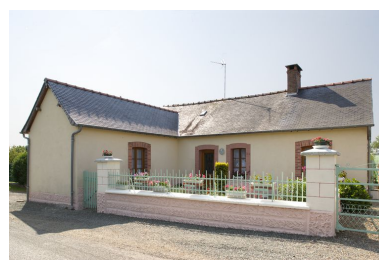
Le logis indépendant et son étable. Phot. François Lasa IVR52_20055301685NUCA
