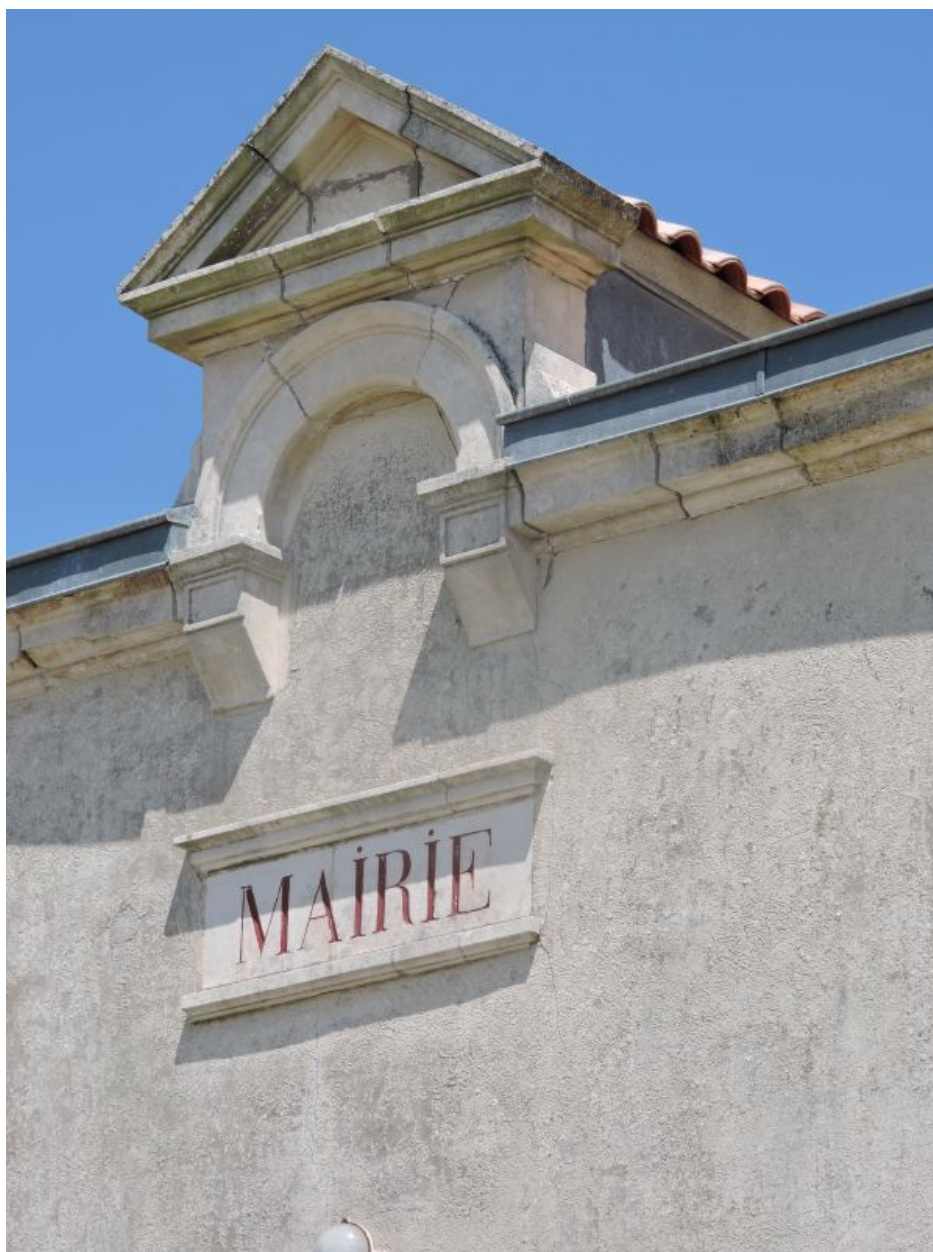
La fausse lucarne et le cartouche réemployés de l'ancienne mairie et visibles sur l'actuelle mairie.
