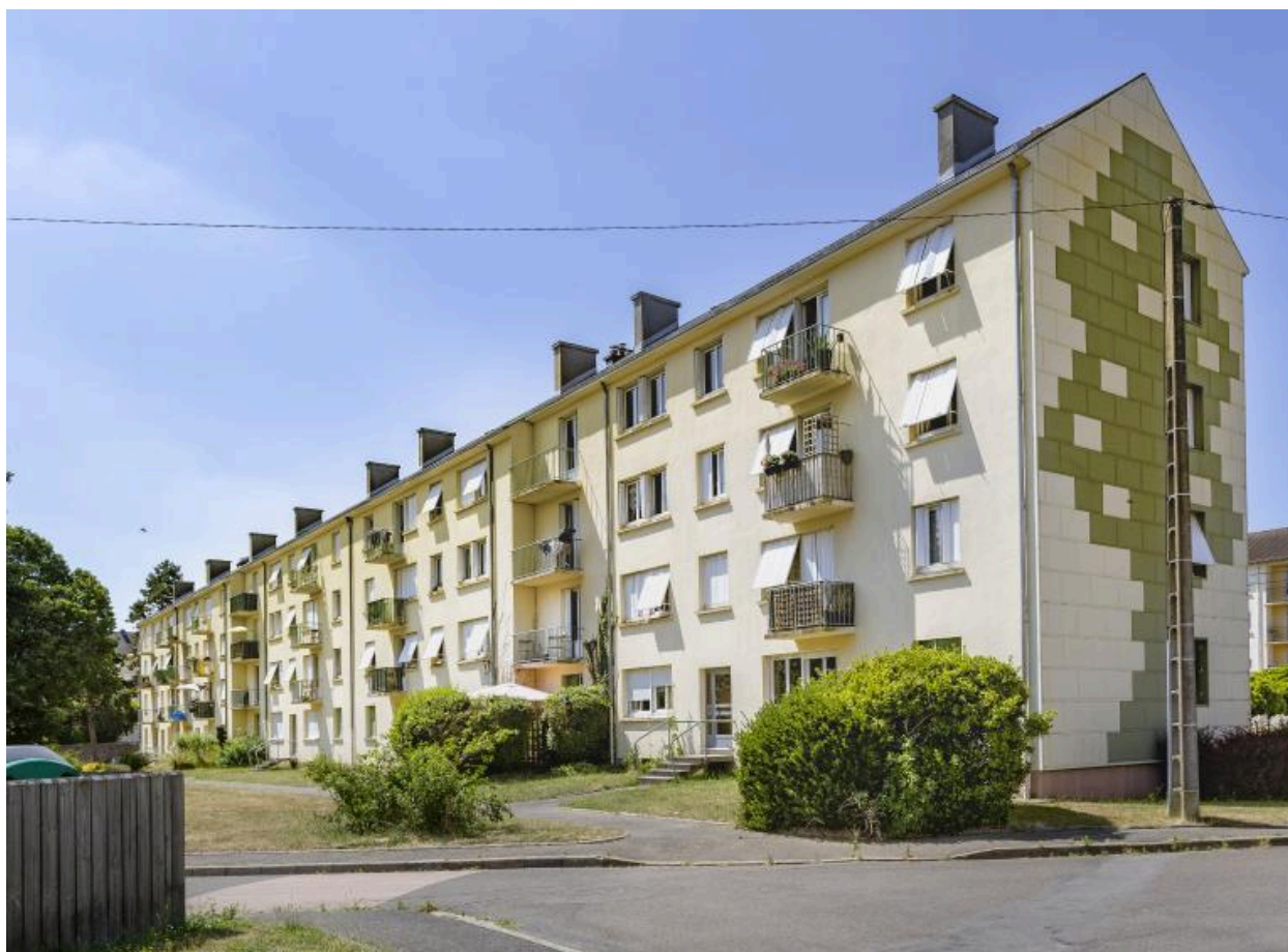
Vue des immeubles A-B-C depuis la rue Péguy.
