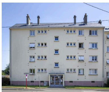
Vue de l'immeuble C depuis la rue du Docteur-Ernest-Mordret. Phot. Pierre-Bernard Fourny IVR52_20197201765NUCA
