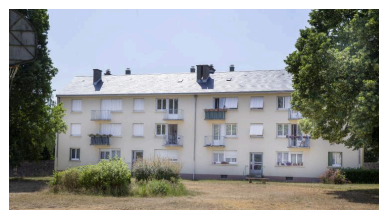
Vue de l'immeuble H depuis les espaces verts. Phot. Pierre-Bernard Fourny IVR52_20197201772NUCA
