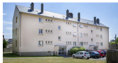
Vue de l'immeuble G depuis la rue Péguy. Phot. Pierre-Bernard Fourny IVR52_20197201779NUCA
