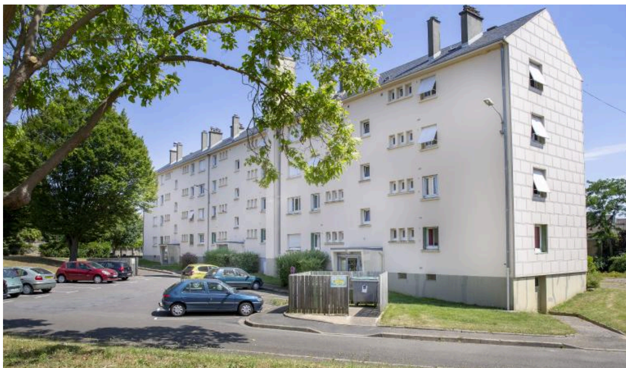
Vue des immeubles E-F depuis la rue Péguy.
