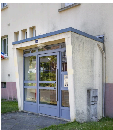
Détail du porche d'entrée de l'immeuble C depuis la rue du Docteur-Ernest-Mordret. Phot. Pierre-Bernard Fourny IVR52_20197201766NUCA
