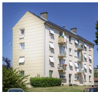
Vue de la façade arrière de l'immeuble D depuis la rue Péguy. Phot. Pierre-Bernard Fourny IVR52_20197201778NUCA
