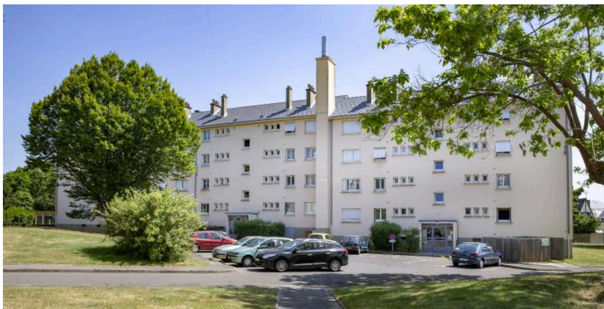
Vue des immeubles E-F depuis la rue Péguy.
