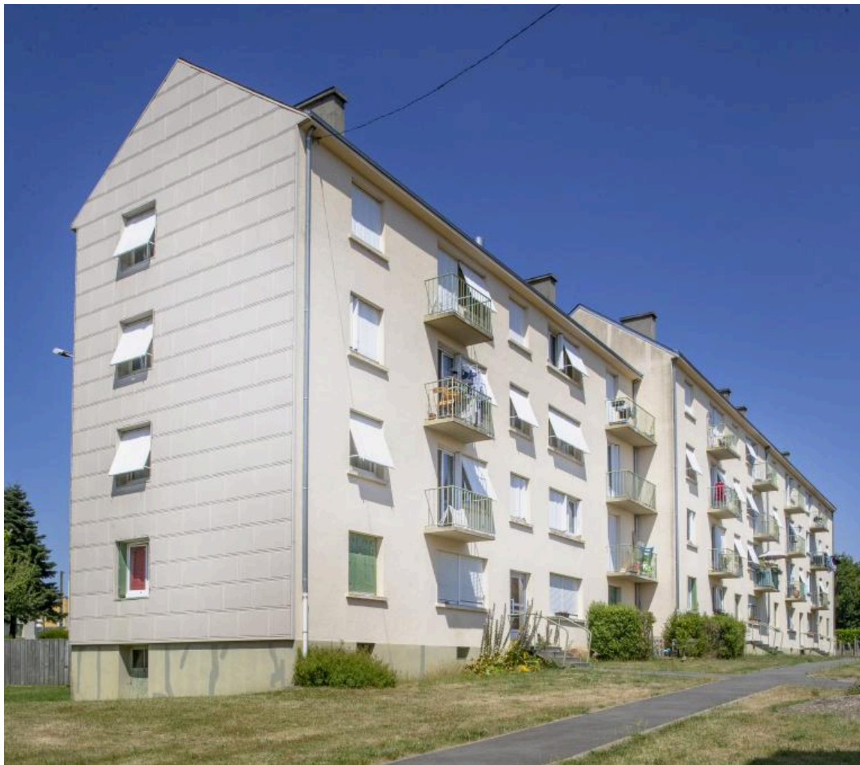
Vue de la façade arrière des immeubles E-F depuis la rue Péguy.
