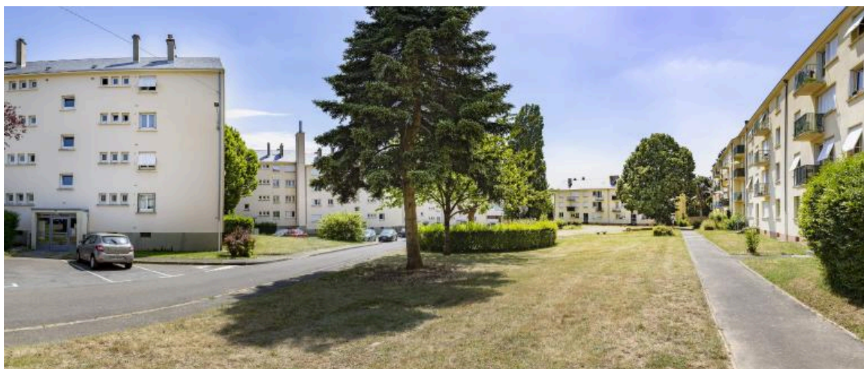
Vue d'ensemble des immeubles du groupe Brindenier depuis les espaces verts.
