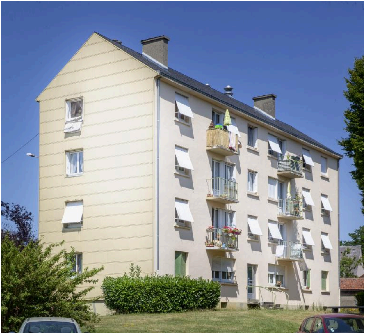
Vue de la façade arrière de l'immeuble D depuis la rue Péguy.
