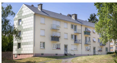
Vue de l'immeuble H depuis la rue Péguy. Phot. Pierre-Bernard Fourny IVR52_20197201781NUCA
