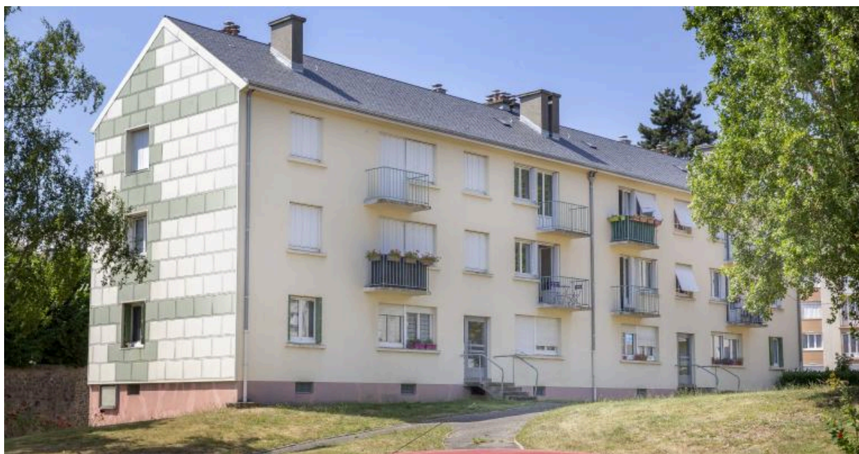
Vue de l'immeuble H depuis la rue Péguy.
