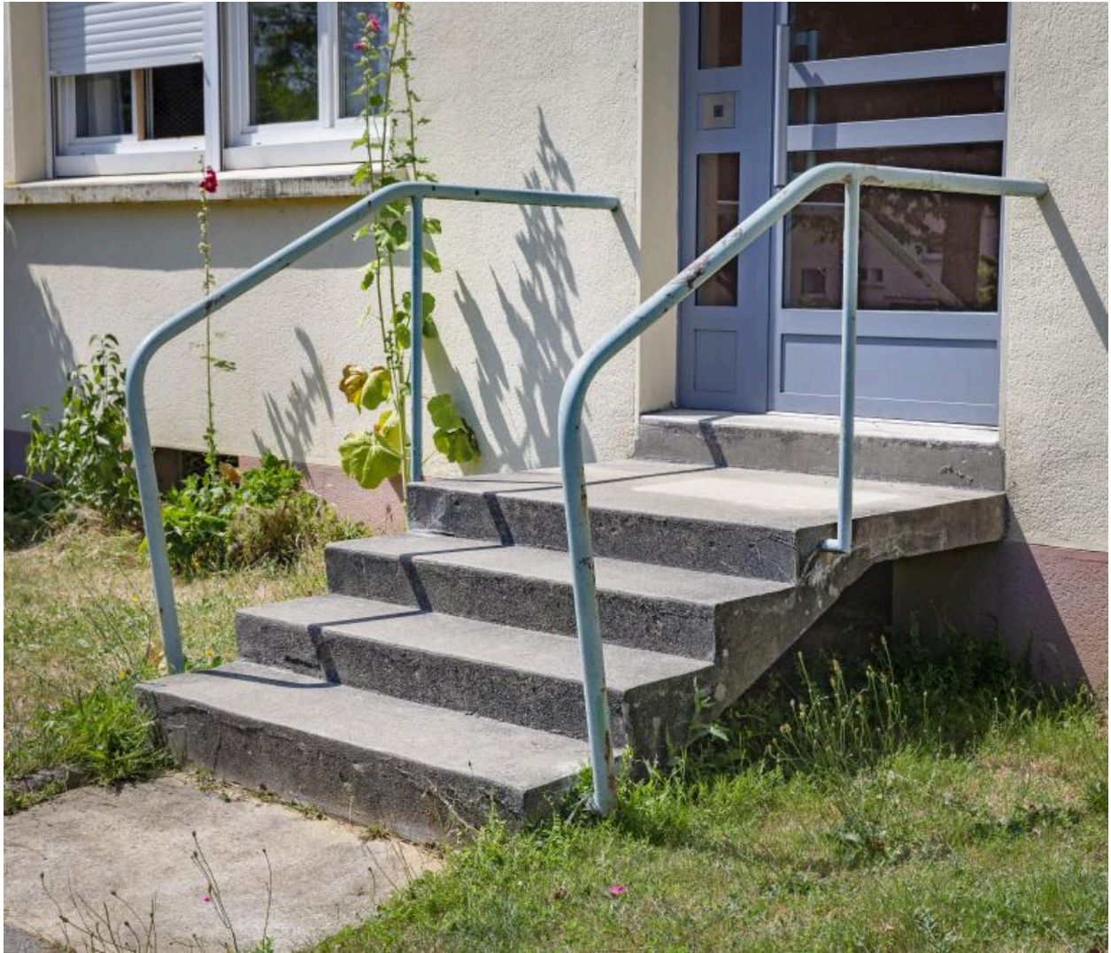
Détail de la volée suspendue de l'escalier d'accès de l'immeuble B depuis les espaces verts.
