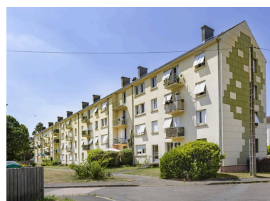
Vue des immeubles A- B-C depuis la rue Péguy. Phot. Pierre-Bernard Fourny IVR52_20197201768NUCA
