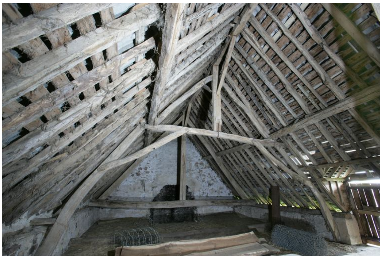
La charpente de l'ancien logis-étable vue depuis le nord.
