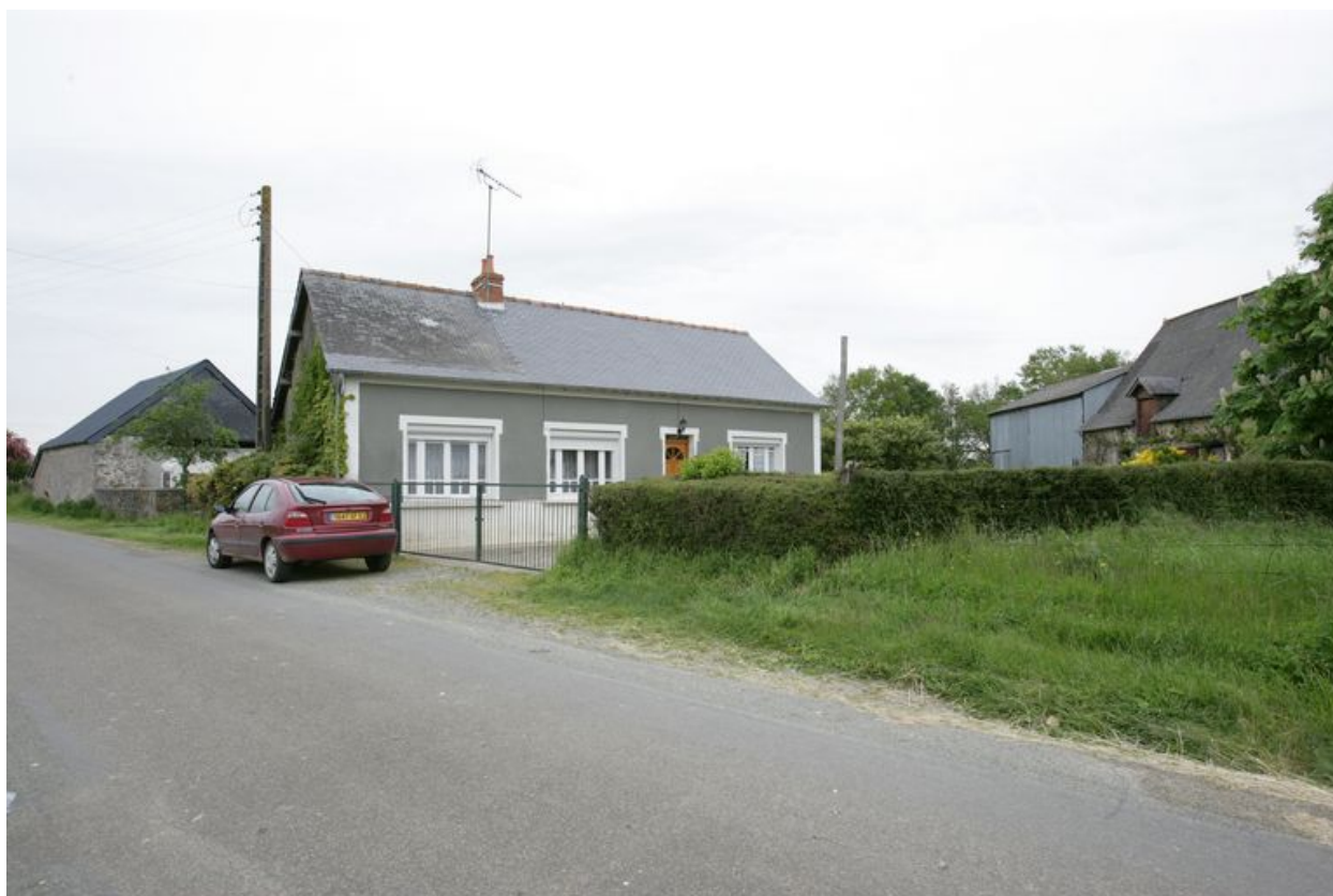
Vue d'ensemble depuis la route au sud : la remise, le logis et l'ancien logis-étable.
