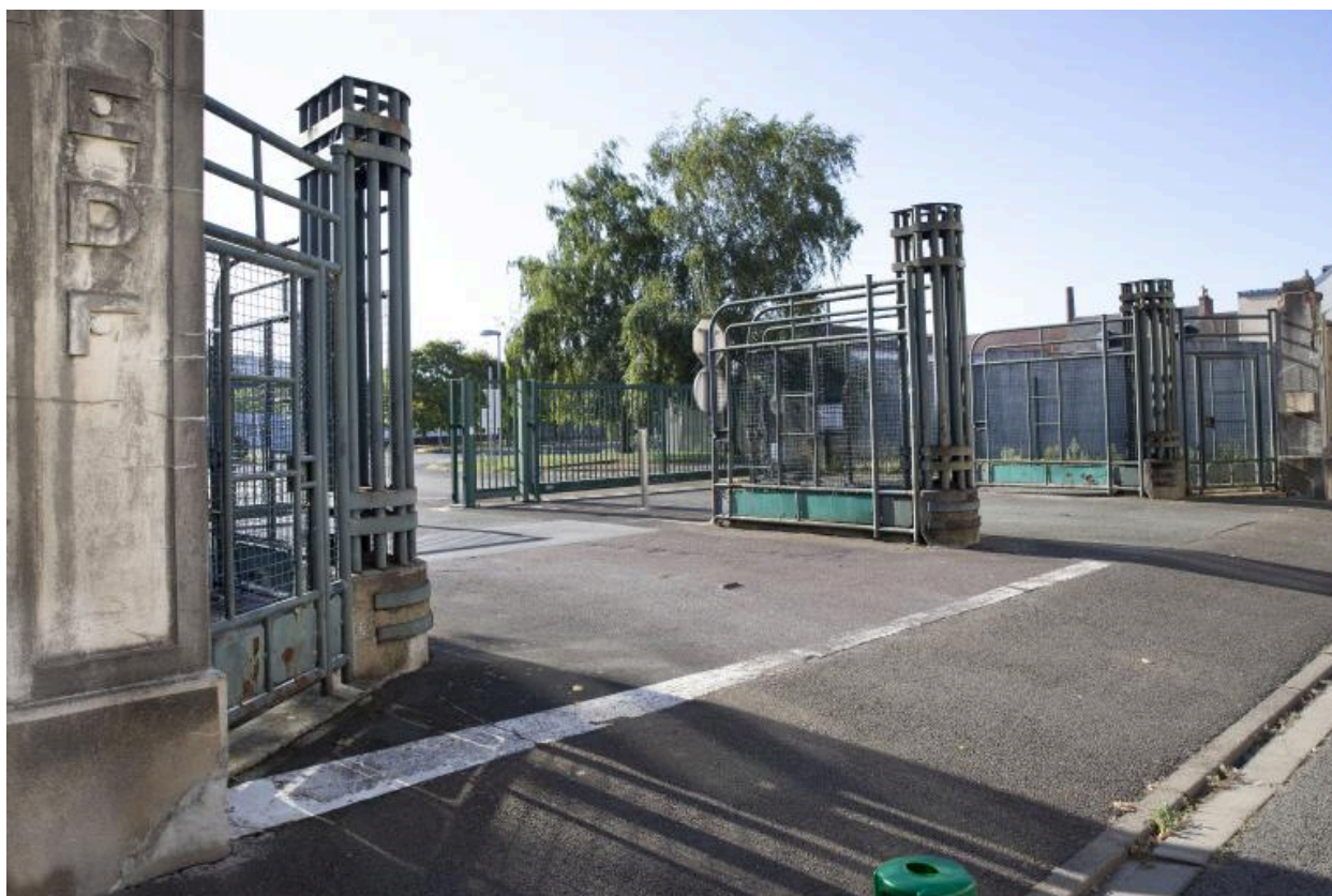
Vue de l'entrée de l'usine EDF-GDF.
