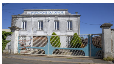
Vue du bâtiment en béton des compagnons du devoirs à proximité du magasin général. Phot. Pierre-Bernard Fourny IVR52_20197202153NUCA
