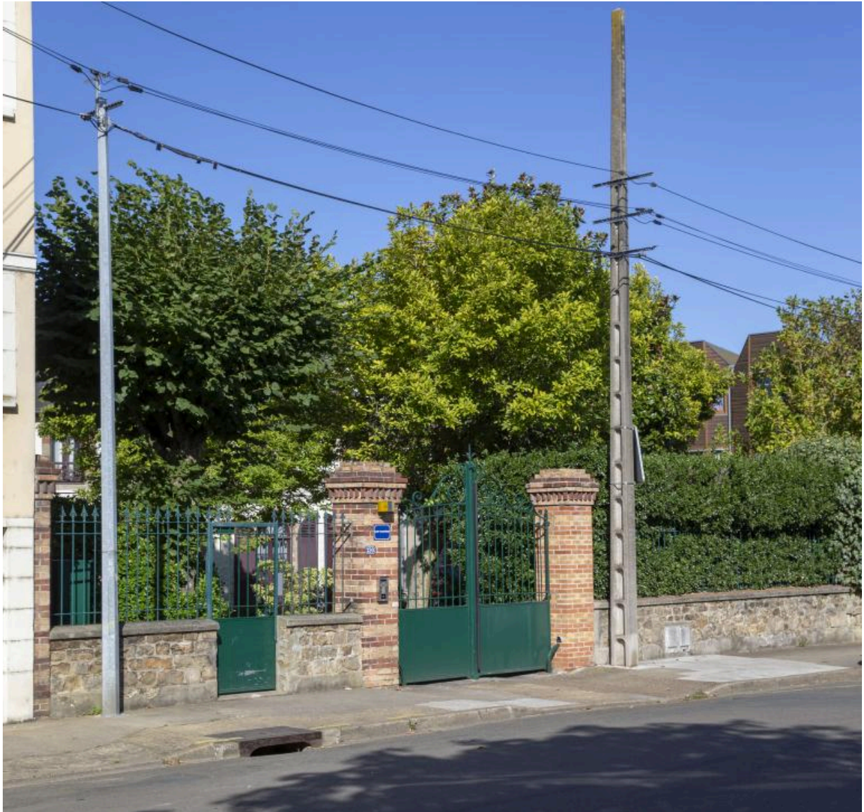
Vue de l'entrée de l'ancienne biscuiterie quai Amiral Lalande.
