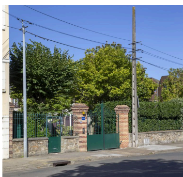
Vue de l'entrée de l'ancienne biscuiterie quai Amiral Lalande. Phot. Pierre-Bernard Fourny IVR52_20197202139NUCA
