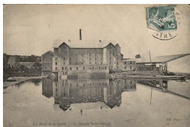
Vue des moulins de Saint-Georges depuis la Sarthe, carte postale. IVR52_20207200789NUCA
