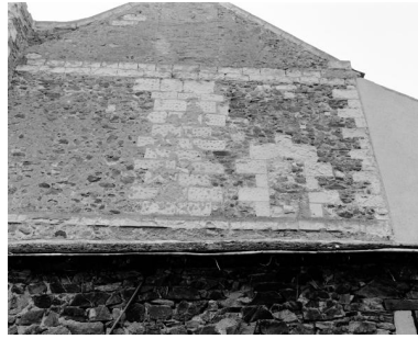
Façade latérale gauche, détail d'ouvertures murées, 1985. Phot. Bruno Rousseau IVR52_19854902243X
