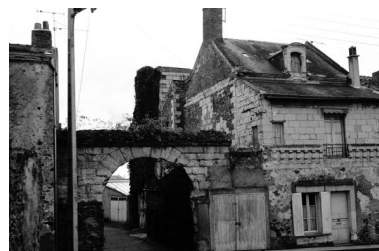
Portail et façade antérieure, avant restauration, 1972. Phot. Marie-Anne Eon IVR52_19724900372Z
