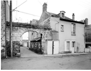
Portail et façade antérieure, après restauration, 1985. Phot. Bruno Rousseau IVR52_19854902256V
