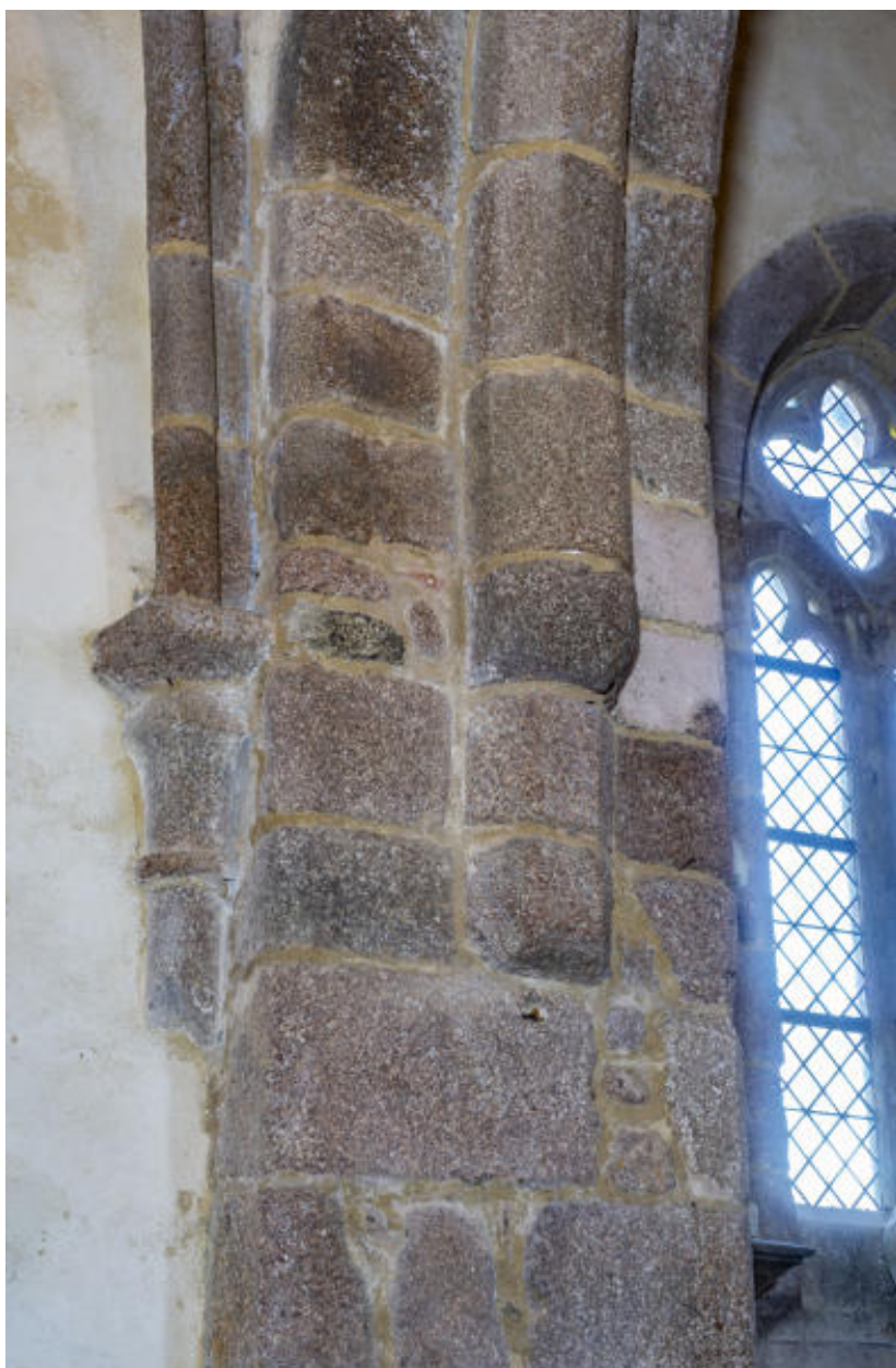
Un détail d'un pilier du choeur et d'un départ de voûte.
