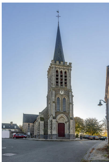
L'église depuis l'ouest. Phot. Pierre-Bernard Fourny IVR52_20215301628NUCA
