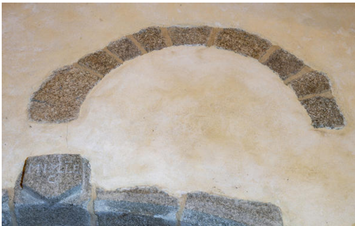
Une trace d'arc de baie et une date portée à l'entrée de la chapelle sud.
