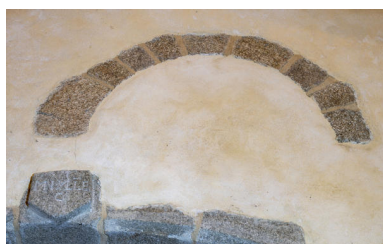
Une trace d'arc de baie et une date portée à l'entrée de la chapelle sud. Phot. Pierre-Bernard Fourny IVR52_20215301649NUCA
