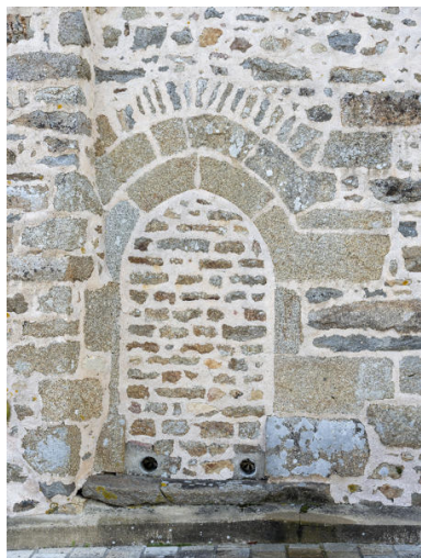
La porte murée du côté sud de la nef. Phot. Pierre-Bernard Fourny IVR52_20215301629NUCA
