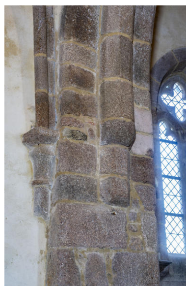
Un détail d'un pilier du chœur et d'un départ de voûte.
