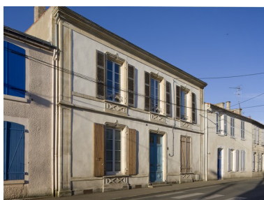
Façade nord, sur rue. Phot. Patrice Giraud IVR52_20098500383NUCA
