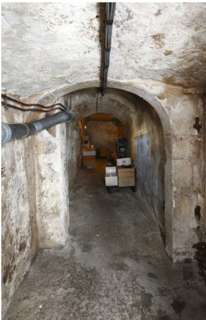
Vue de la cave prise vers l'est, du bas de l'escalier d'accès.
