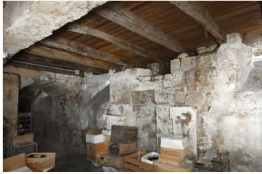
Vue de la cave prise du nord-est, en direction de la rue, montrant les reprises de maçonnerie. Phot. Patrice Giraud IVR52_20098500185NUCA
