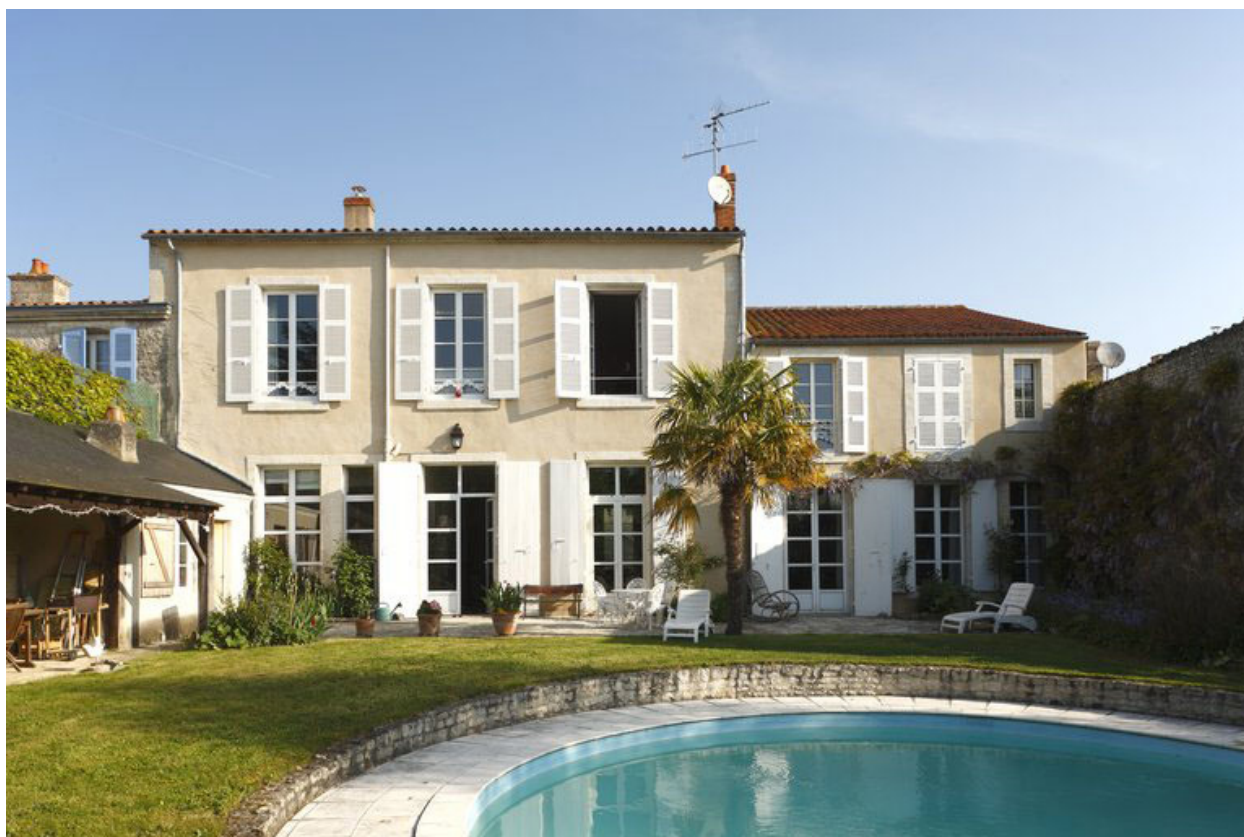
Façade sud, donnant sur le jardin.
