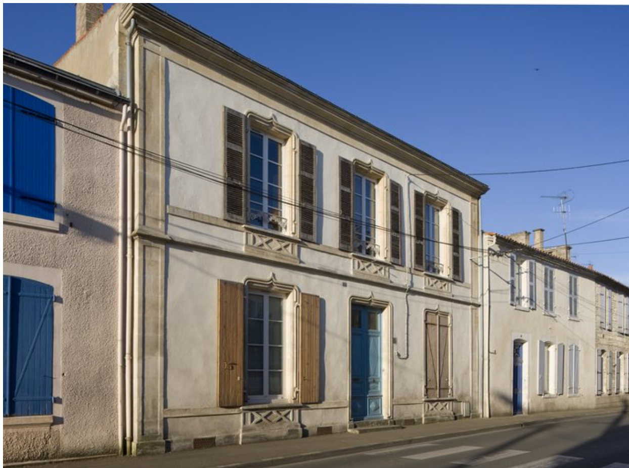
Façade nord, sur rue.
