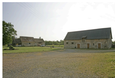
Les bâtiments vus depuis le sud-ouest : la remise, l'étable. Phot. François Lasa IVR52_20075301740NUCA
