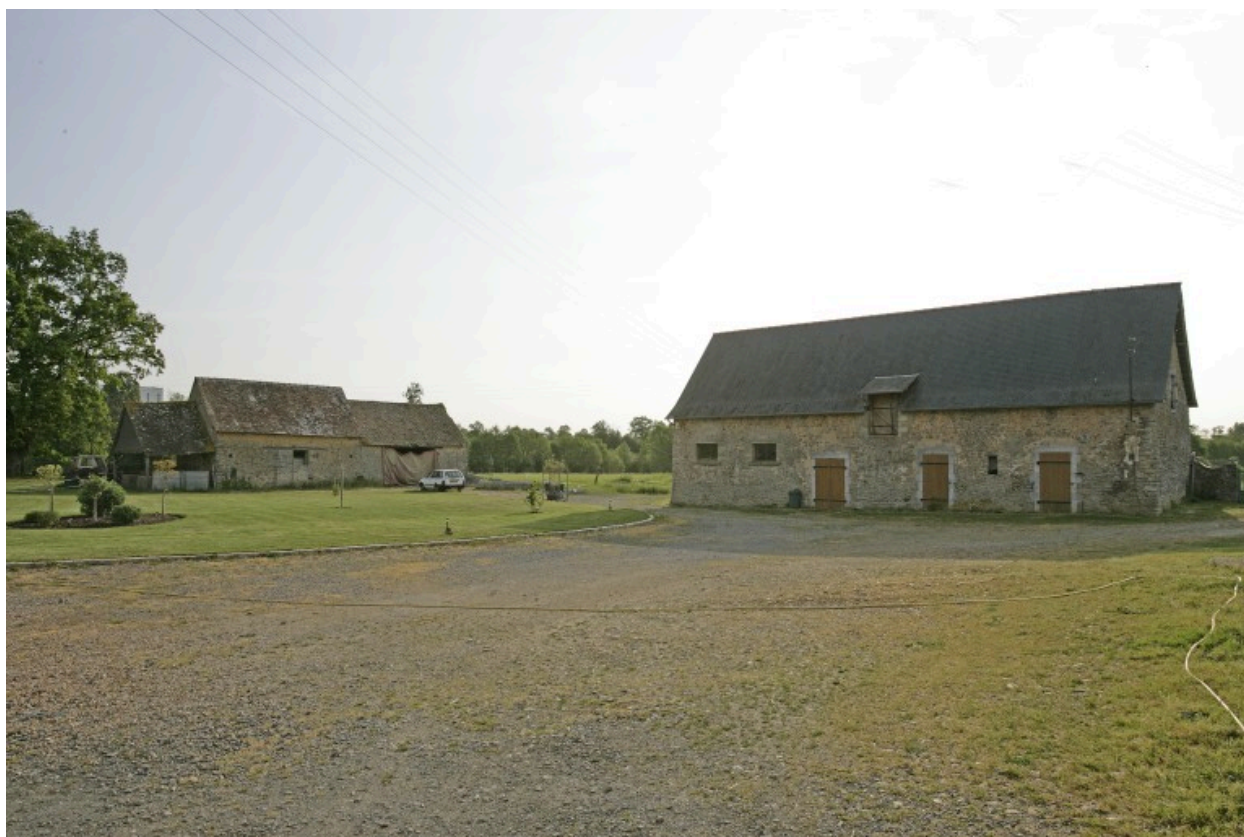
Les bâtiments vus depuis le sud-ouest : la remise, l'étable.
