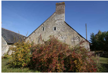
Maison 3 : pignon ouest. Phot. Jean-Baptiste Darrasse IVR52_20087202394NUCA
