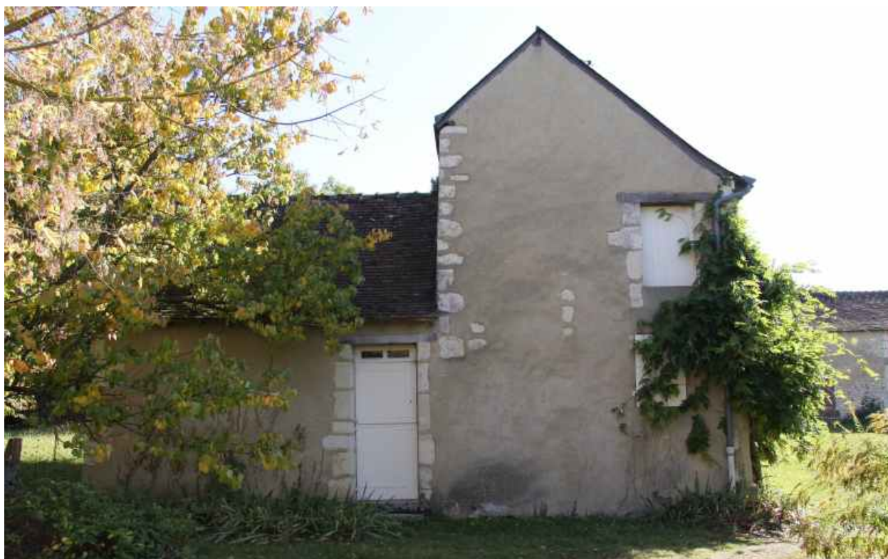
Maison 1 : pignon nord.
