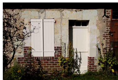
Maison 2, détail : porte et fenêtre. Phot. Jean-Baptiste Darrasse IVR52_20087202395NUCA
