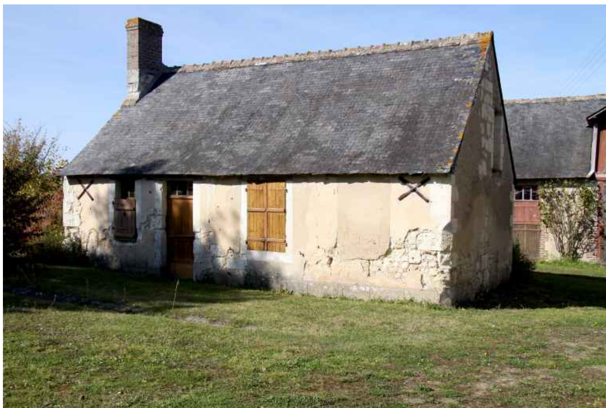
Maison 3 : façade antérieure.
