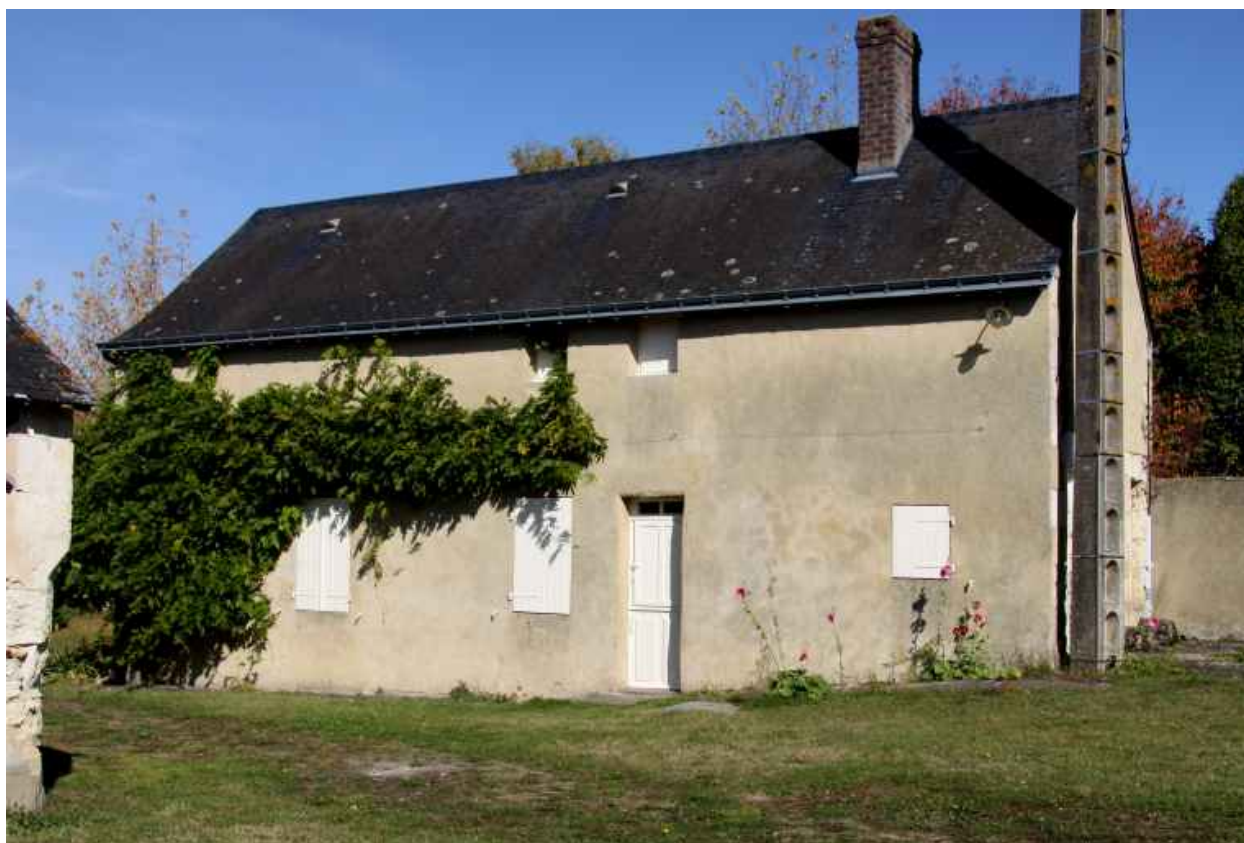
Maison 1, façade sur cour : comble à surcroît.
