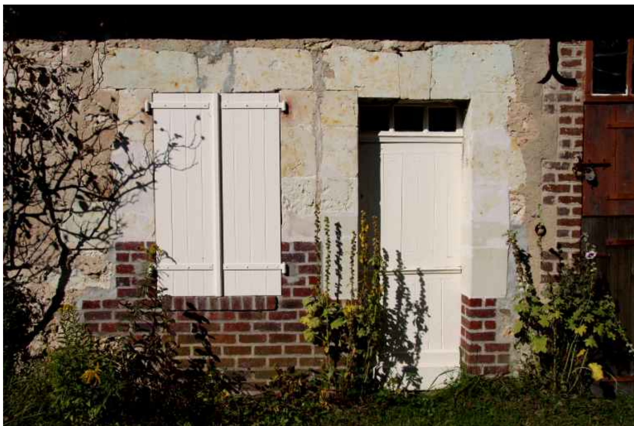
Maison 2, détail : porte et fenêtre.
