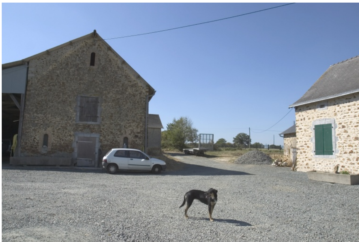
Ferme est : le pignon est de l'étable-grange et le logis vus depuis la cour à l'est.
