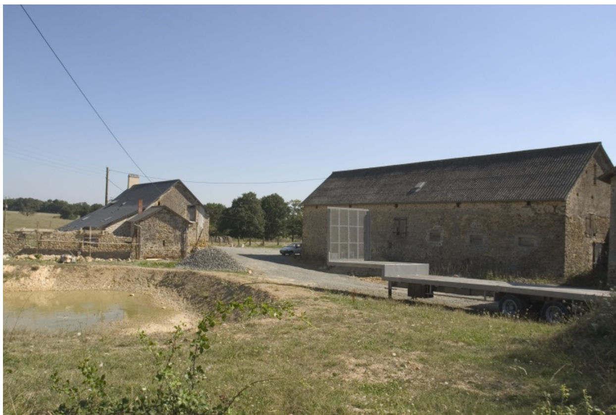
Ferme est. Vue d'ensemble depuis le nord-ouest : le logis et les porcheries, l'étable grange.
