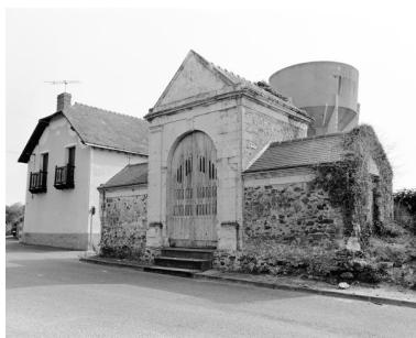
Façade antérieure de la chapelle. Phot. Bruno Rousseau IVR52_19854901606X
