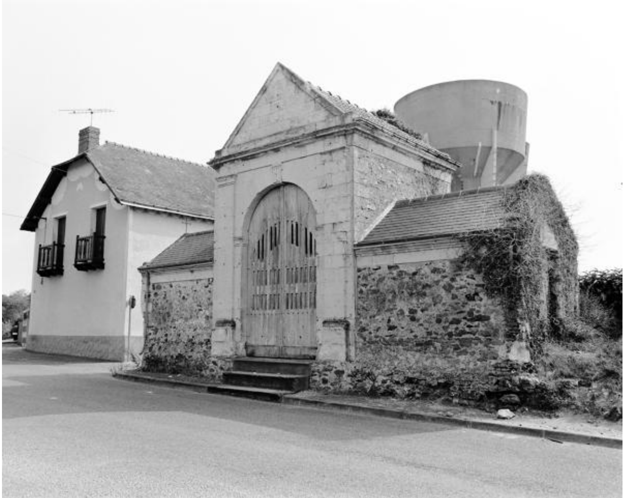
Façade antérieure de la chapelle.
