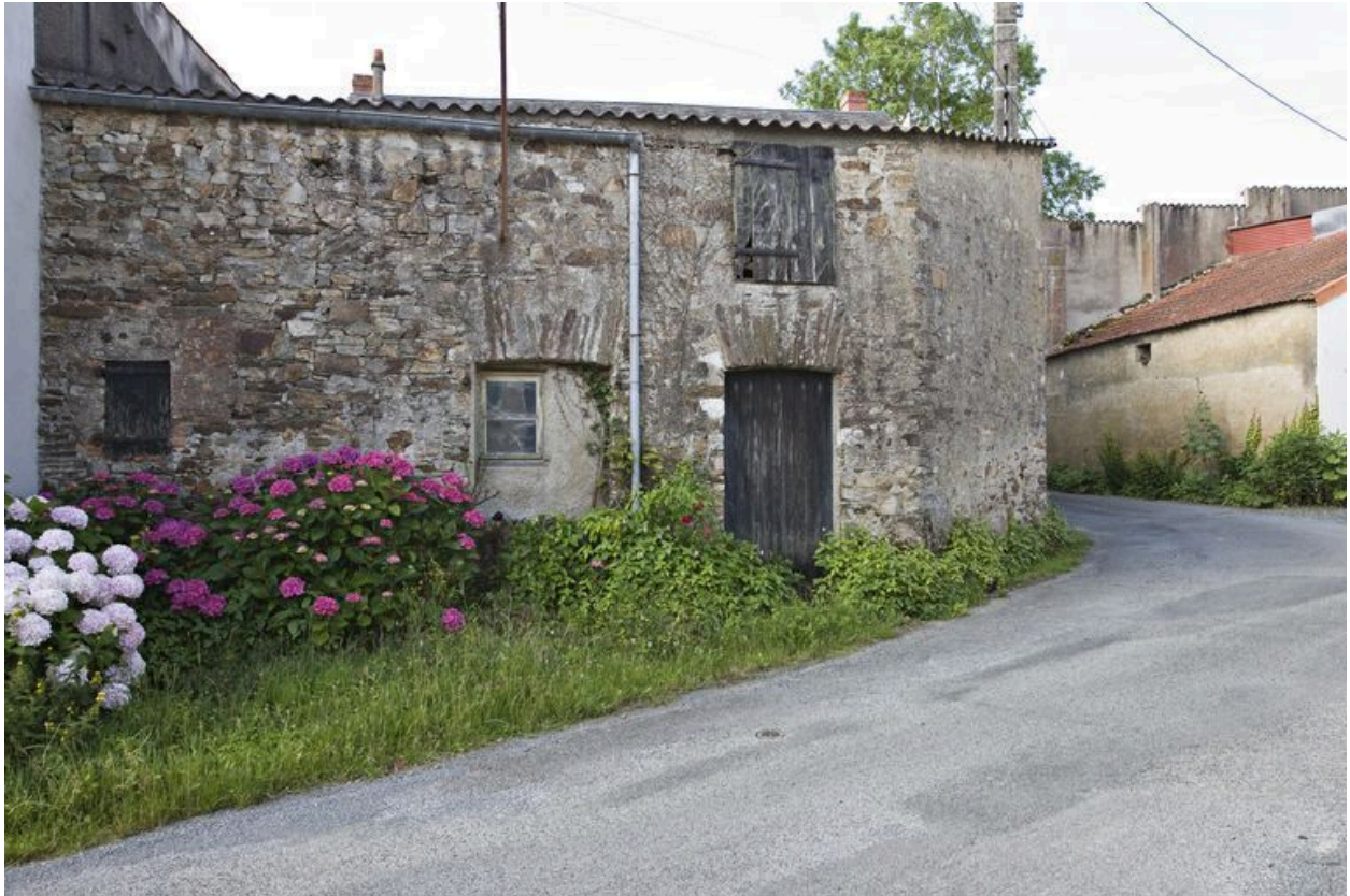
La cave et l'ancienne maison, 18e siècle : élévation nord.
