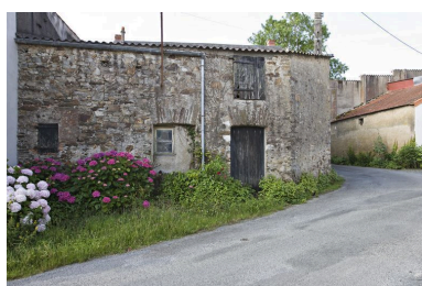
La cave et l'ancienne maison, 18e siècle : élévation nord. Phot. Yves Guillotin IVR52_20114400653NUCA
