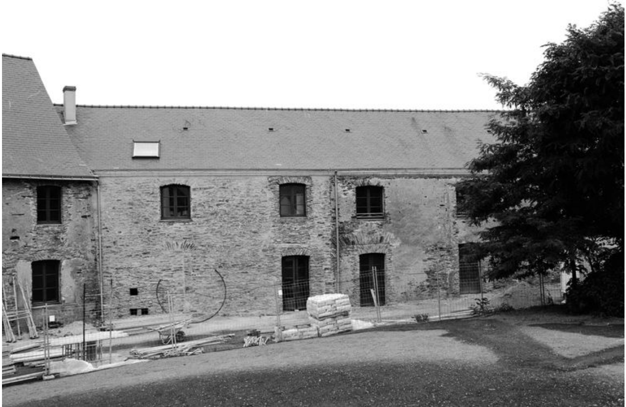
Bâtiment de l'ancienne aumônerie Saint-Jean, salle des malades à l'origine ?, puis buanderie et boulangerie au 19e siècle. Face est. En cours de transformation.
