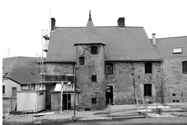
Bâtiment de l'ancienne aumônerie Saint-Jean, logis, face est. En cours de transformation. Phot. Christian Cussonneau IVR52_19994901678Z
