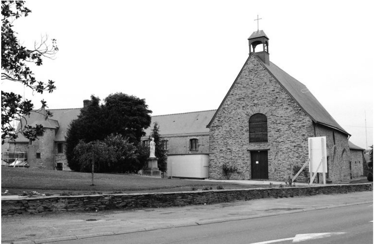
Bâtiment de l'ancienne aumônerie Saint-Jean, vue d'ensemble depuis le nord-est. De gauche à droite, logis, salles des malades, chapelle.
