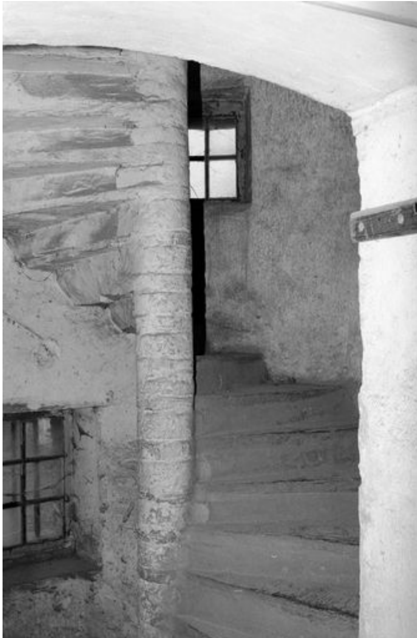
Bâtiments de l'ancienne aumônerie Saint-Jean, logis, intérieur de la tour d'escalier de la face est, détail de la vis.
