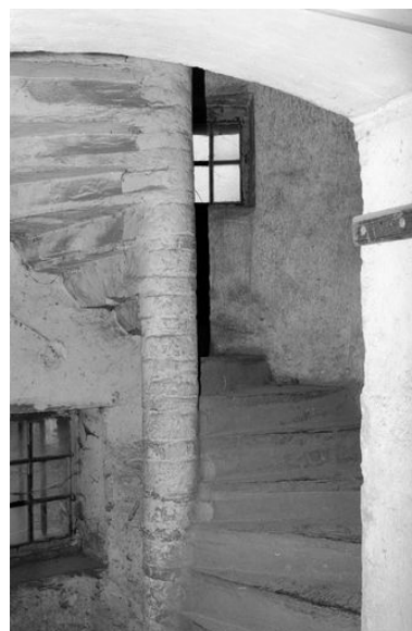
Bâtiments de l'ancienne aumônerie Saint-Jean, logis, intérieur de la tour d'escalier de la face est, détail de la vis. Phot. Christian Cussonneau IVR52_19994900467Z
