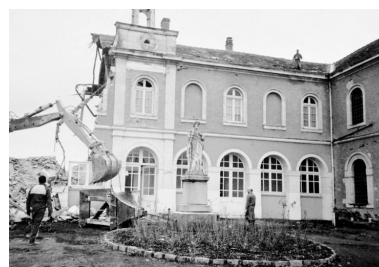
Hôpital Saint-Joseph, bâtiment construit sur les plans de l'architecte Ferdinand Lachèse, en 1845. Façade antérieure, partie droite, lors de sa démolition en 1992. Phot. Bruno Rousseau IVR52_19994900889X
