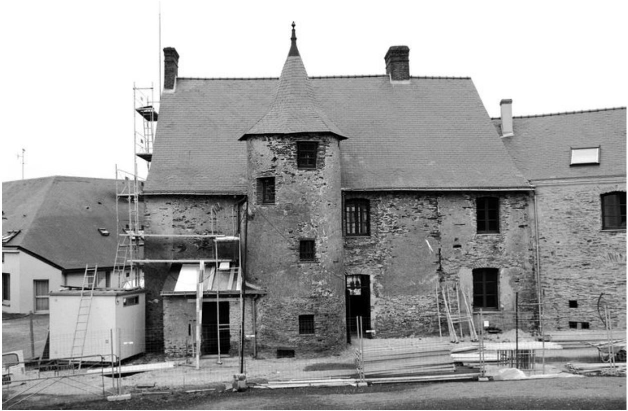
Bâtiment de l'ancienne aumônerie Saint-Jean, logis, face est. En cours de transformation.
