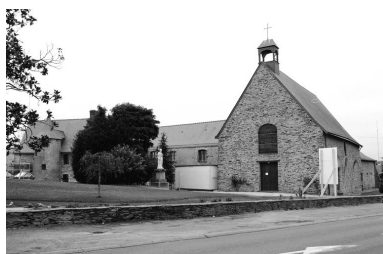
Bâtiment de l'ancienne aumônerie Saint-Jean, vue d'ensemble depuis le nord-est. De gauche à droite, logis, salles des malades, chapelle. Phot. Christian Cussonneau IVR52_19994901677Z
