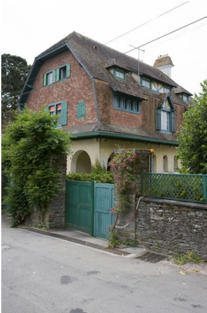
Ker Maloute, vue des élévations, côté sud-est.
