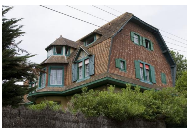
Toiture, vue du sud-ouest. Phot. Denis Pillet IVR52_20094400668NUCA
