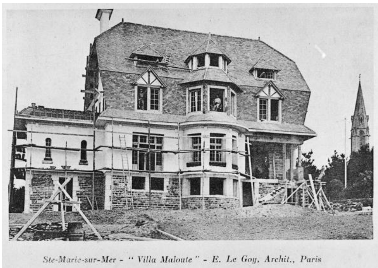
Elévation sud de la villa en construction. Photographie ancienne.
