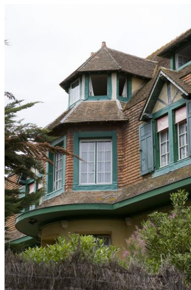
Détail de la toiture. Phot. Denis Pillet IVR52_20094400669NUCA
