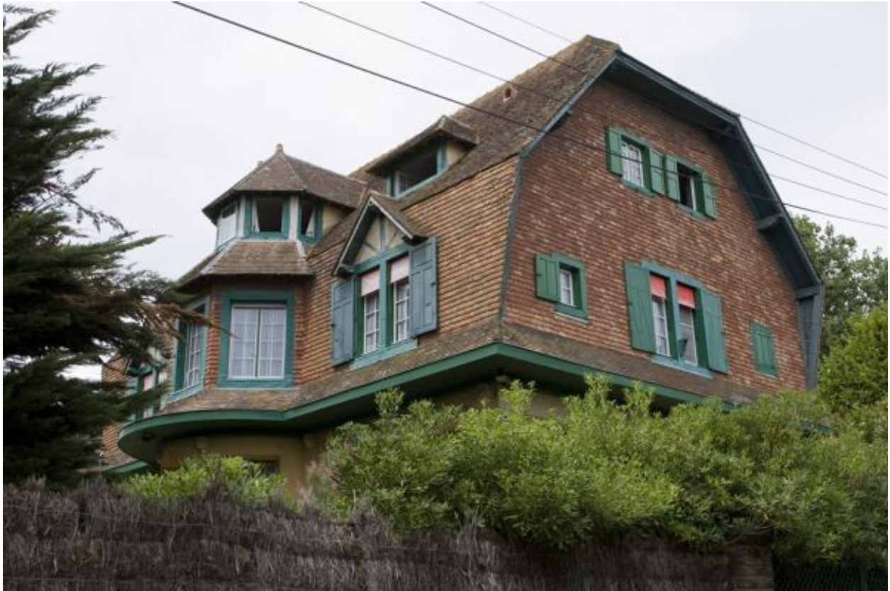
Toiture, vue du sud-ouest.
