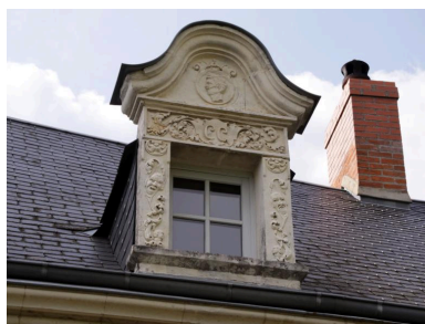
Maison, façade sur cour : détail d'une lucarne (fin XIXe s.). Initiales : CC. Phot. Jean-Baptiste Darrasse IVR52_20107200868NUCA
