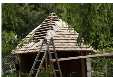
Abri de jardin en construction. Phot. Jean-Baptiste Darrasse IVR52_20107200857NUCA
