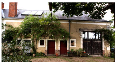
Maison et dépendance, façades sur cour. Phot. Jean-Baptiste Darrasse IVR52_20107200864NUCA
