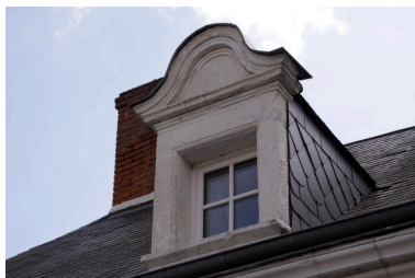
Maison, façade sur rue (chemin de la Fontaine Blineau) : détail de la lucarne. Date portée : 1896. Phot. Jean-Baptiste Darrasse IVR52_20107200826NUCA
