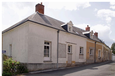
Maison, façade sur rue (chemin de la Fontaine Blineau). Phot. Jean-Baptiste Darrasse IVR52_20107200825NUCA
