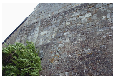
Traces d'un pignon plus bas et de différentes reprises de maçonnerie. Phot. David Huard IVR52_20047205450NUCA
