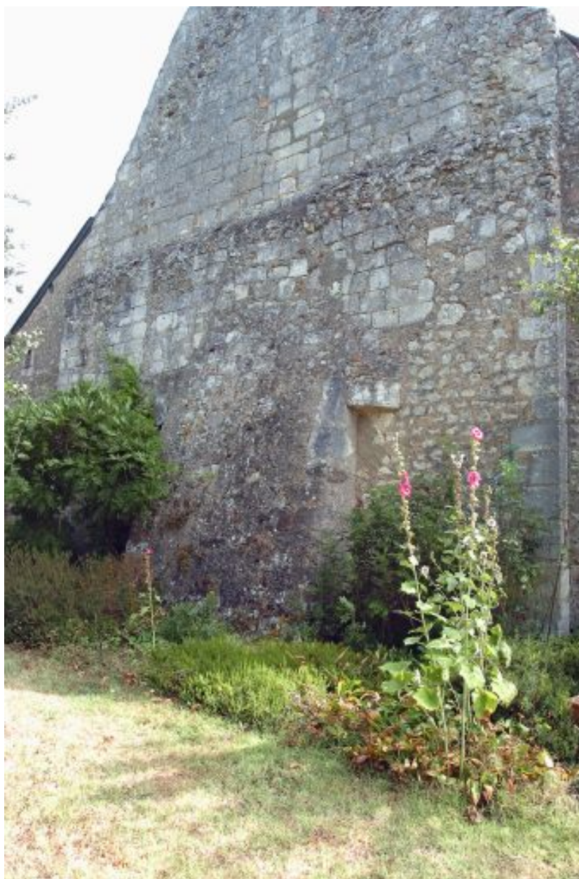
Pignon ouest : vestiges de constructions antérieures (hotte de cheminée adossée ?)
