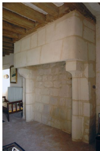
1er étage, pignon est : cheminée. Phot. David Huard IVR52_20047205454NUCA
