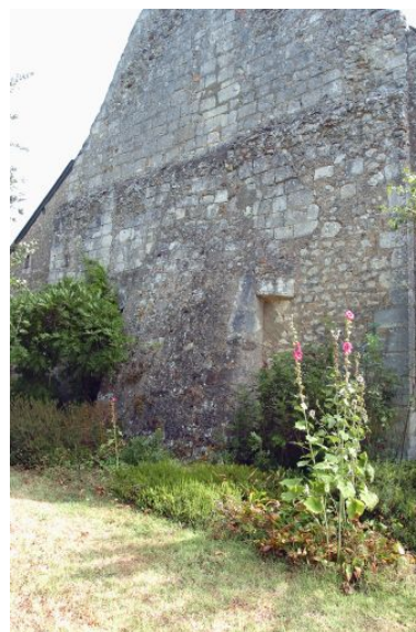
Pignon ouest : vestiges de constructions antérieures (hotte de cheminée adossée ?) Phot. David Huard IVR52_20047205449NUCA
