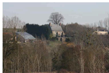
Vue d'ensemble prise du pont sur le Loir. Phot. Jean-Baptiste Darrasse IVR52_20067205114NUCA
