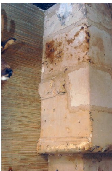
Rez-de-chaussée, pignon est : vestiges des moulures du linteau de la hotte. Phot. David Huard IVR52_20047205457NUCA
