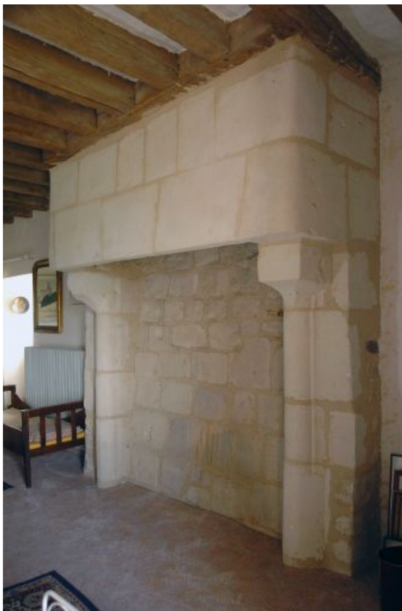
1er étage, pignon est : cheminée.
