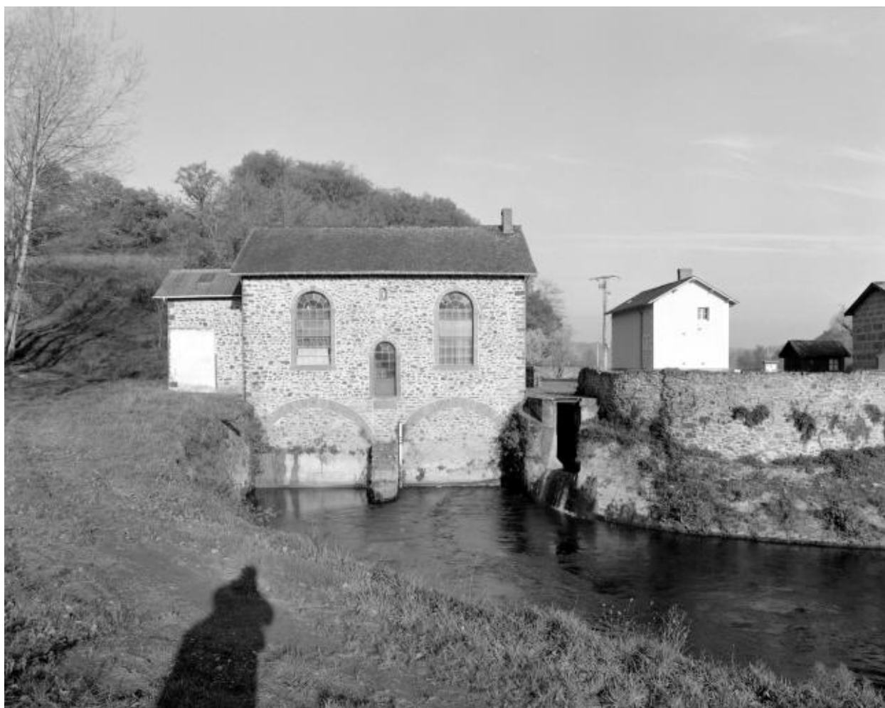
Façade sud-est et canal de fuite.
