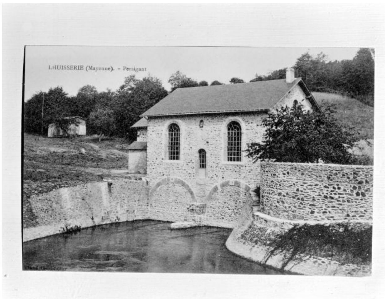
Façade sud-est et canal de fuite.
