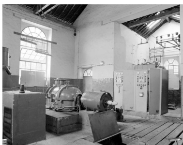
Vue intérieure. A gauche, le multiplicateur relié à la turbine sud- ouest. Au centre l'alternateur. A droite, le tableau de commande, masquant le transformateur. Devant, la trappe d'accès à la turbine. Phot. François Lasa IVR52_20025300697X
