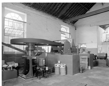
Vue intérieure d'ensemble depuis l'entrée, au nord. A gauche, la commande d'ouverture de la turbine est, le multiplicateur est et sa couroie. A droite, le multiplicateur et l'alternateur reliés à la turbine ouest. au fond, le tableau de commande. Phot. François Lasa IVR52_20025300696X
