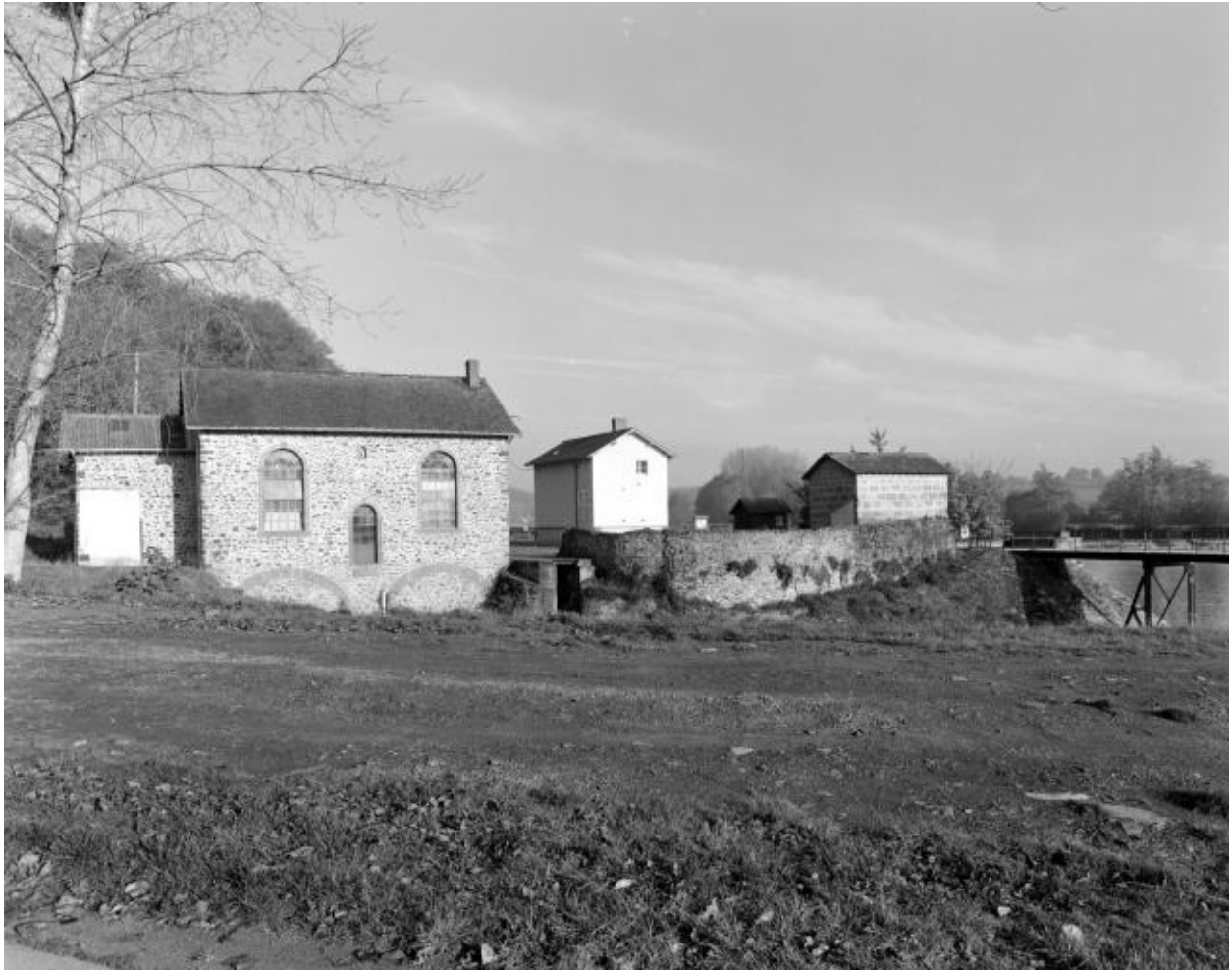
Vue depuis le sud-est : centrale, maison éclésièrre, canal de fuite, passerelle.
