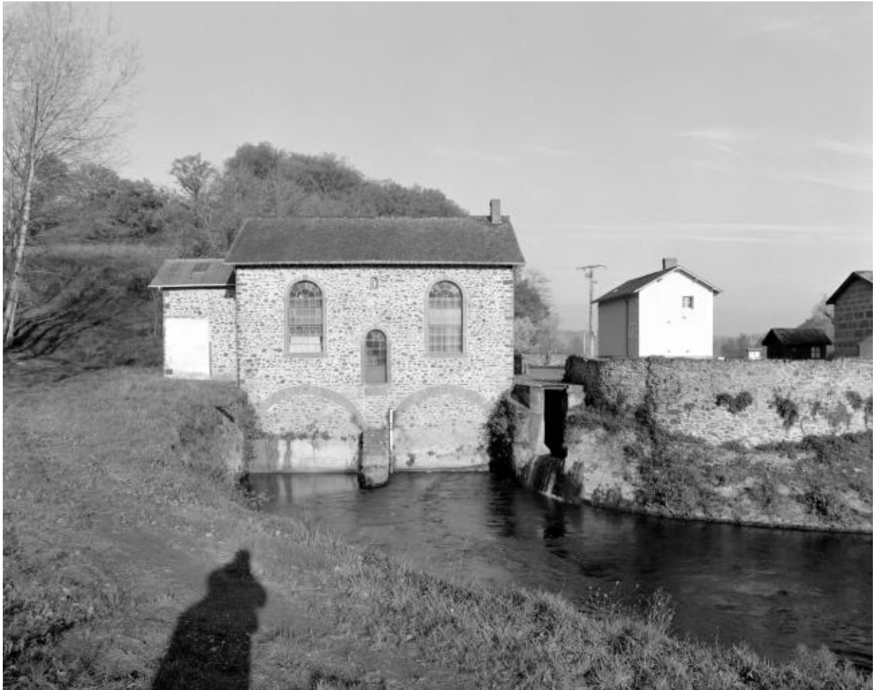
Façade sud-est et canal de fuite.
