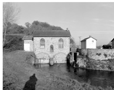
Façade sud-est et canal de fuite. Phot. François Lasa IVR52_20015300624X
