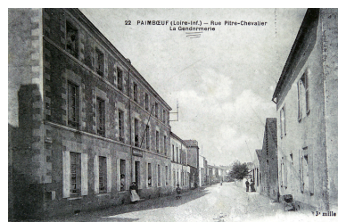
Le haut Paimbœuf, la rue Pitre Chevalier vue prise vers l'aval. Autr. Fernand Chapeau, Phot. Denis (reproduction) Pillet IVR52_20034401782NUCA
