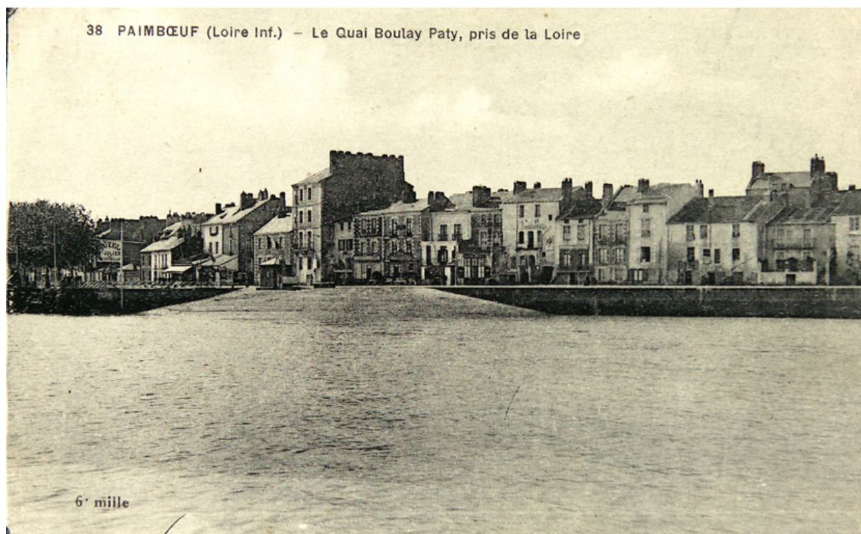
Le quai Boulay-Paty vu depuis la Loire.
