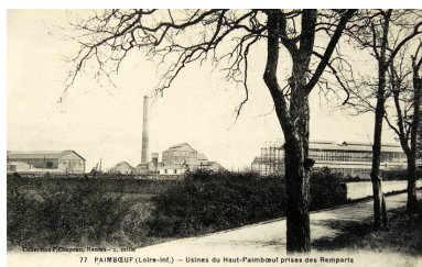
Le haut Paimbœuf, le secteur industriel. Phot. Denis Pillet, Autr. Fernand Chapeau IVR52_20034401808NUCAB
