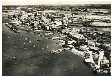
Vue aérienne du haut Paimboeuf à partir du bassin de carénage, vers 1950. Autr. Jean Combier, Phot. Denis (reproduction) Pillet IVR52_20034401867NUCA
