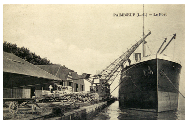
Le quai Sadi-Carnot. Autr. Fonteneau (éditeur), Phot. Denis (reproduction) Pillet IVR52_20034401780NUCA
