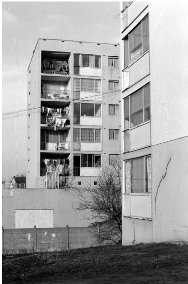
Vue de loggia dans un immeuble des Glonnières. IVR52_20217200016NUCA
