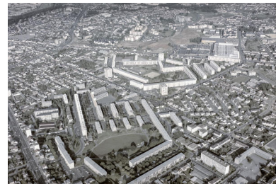
Vue aérienne de la cité du Ronceray et des Glonnières. IVR52_20217200023NUCA
