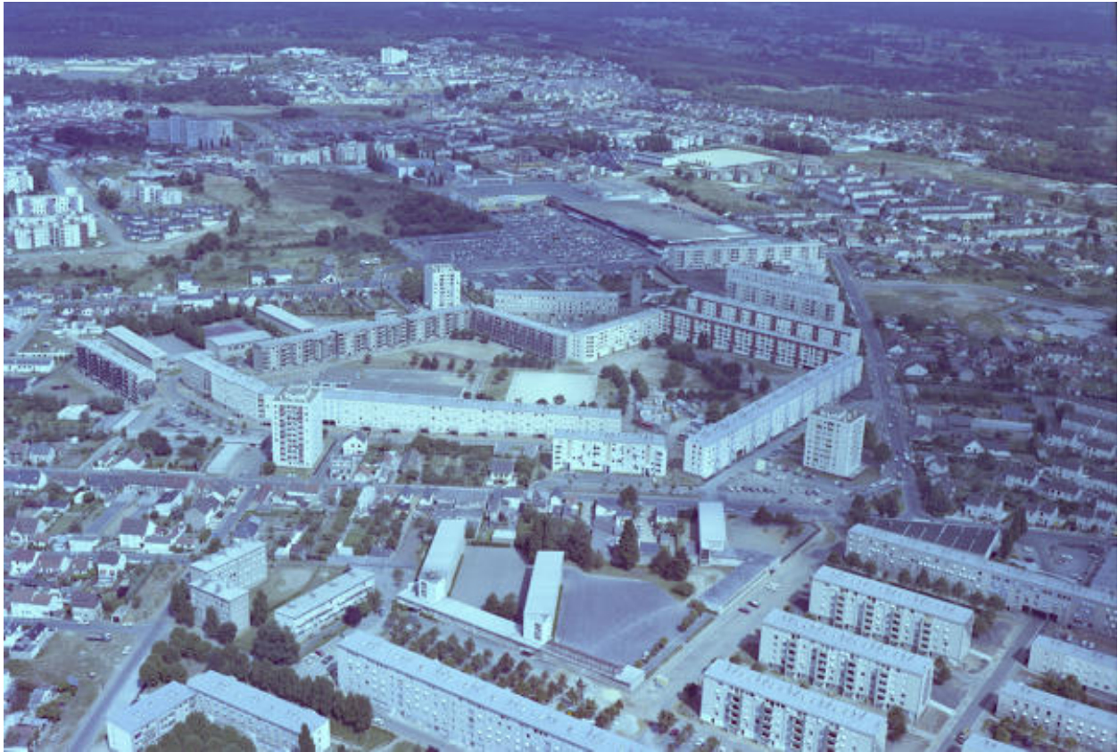
Vue aérienne de la cité des Ronceray-Glonnières.
