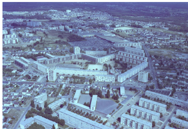
Vue aérienne de la cité des Ronceray-Glonnières. IVR52_20217200017NUCA
