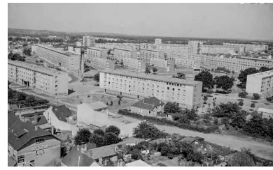
Vue de la cité du Ronceray. IVR52_20217200011NUCA
