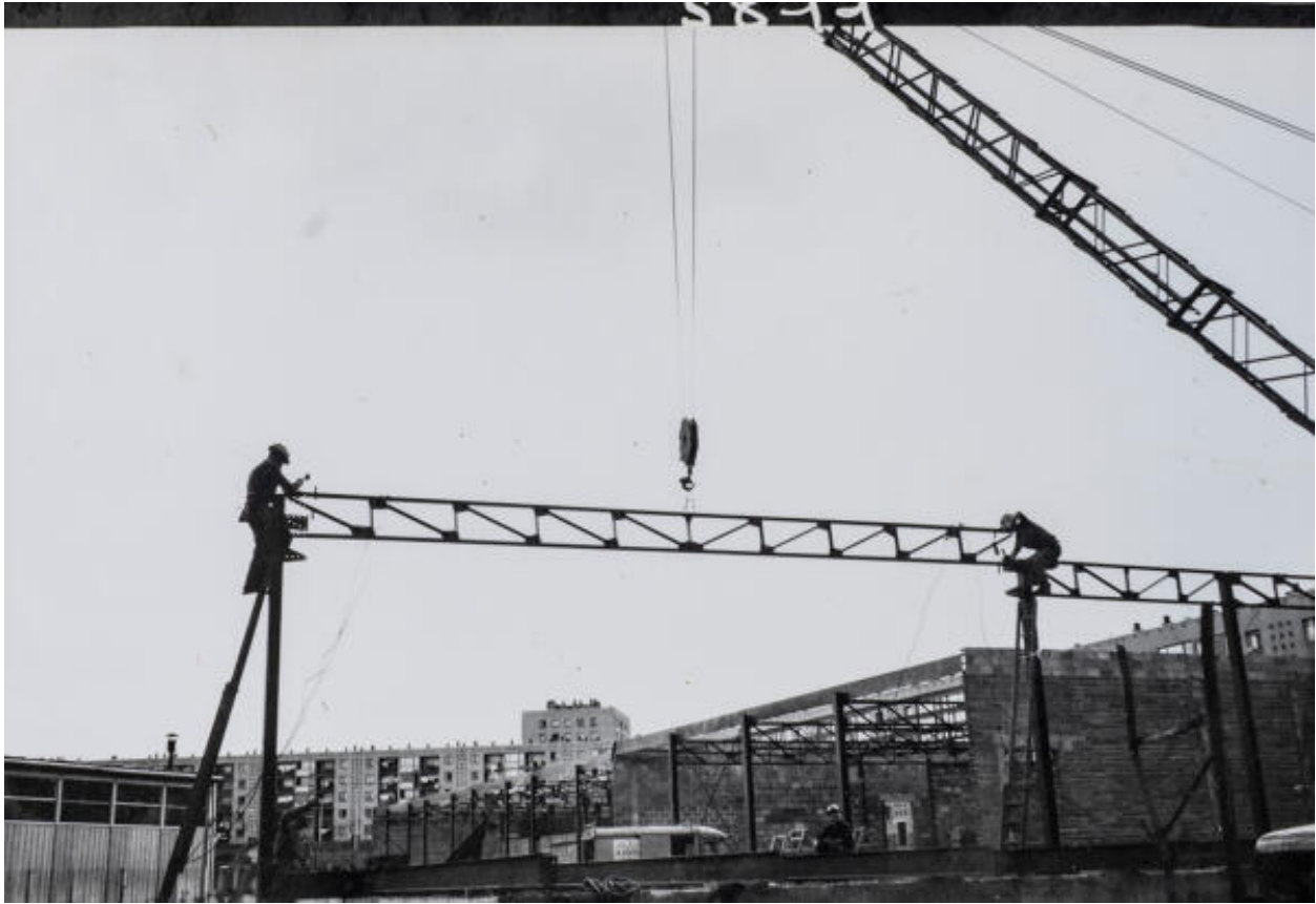
Photographie du chantier du Ronceray, 1958.
