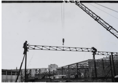
Photographie du chantier du Ronceray, 1958. Repr. Thierry Seldubuisson IVR52_20237200287NUCA
