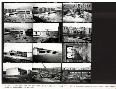
Vues du chantier de la cité des Glonnières. IVR52_20217200012NUCA
