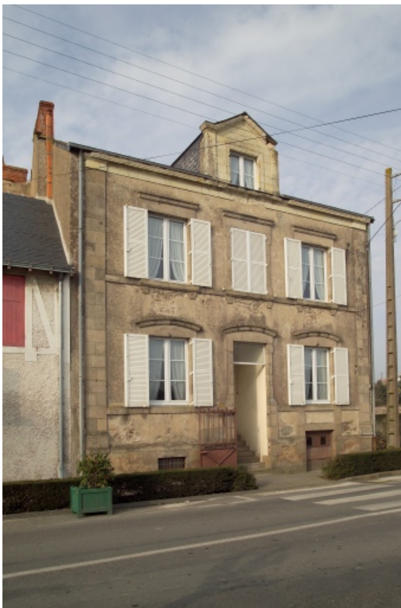
Maison du maître d'exploitation vue depuis la rue du faubourg Saint-Armel.
