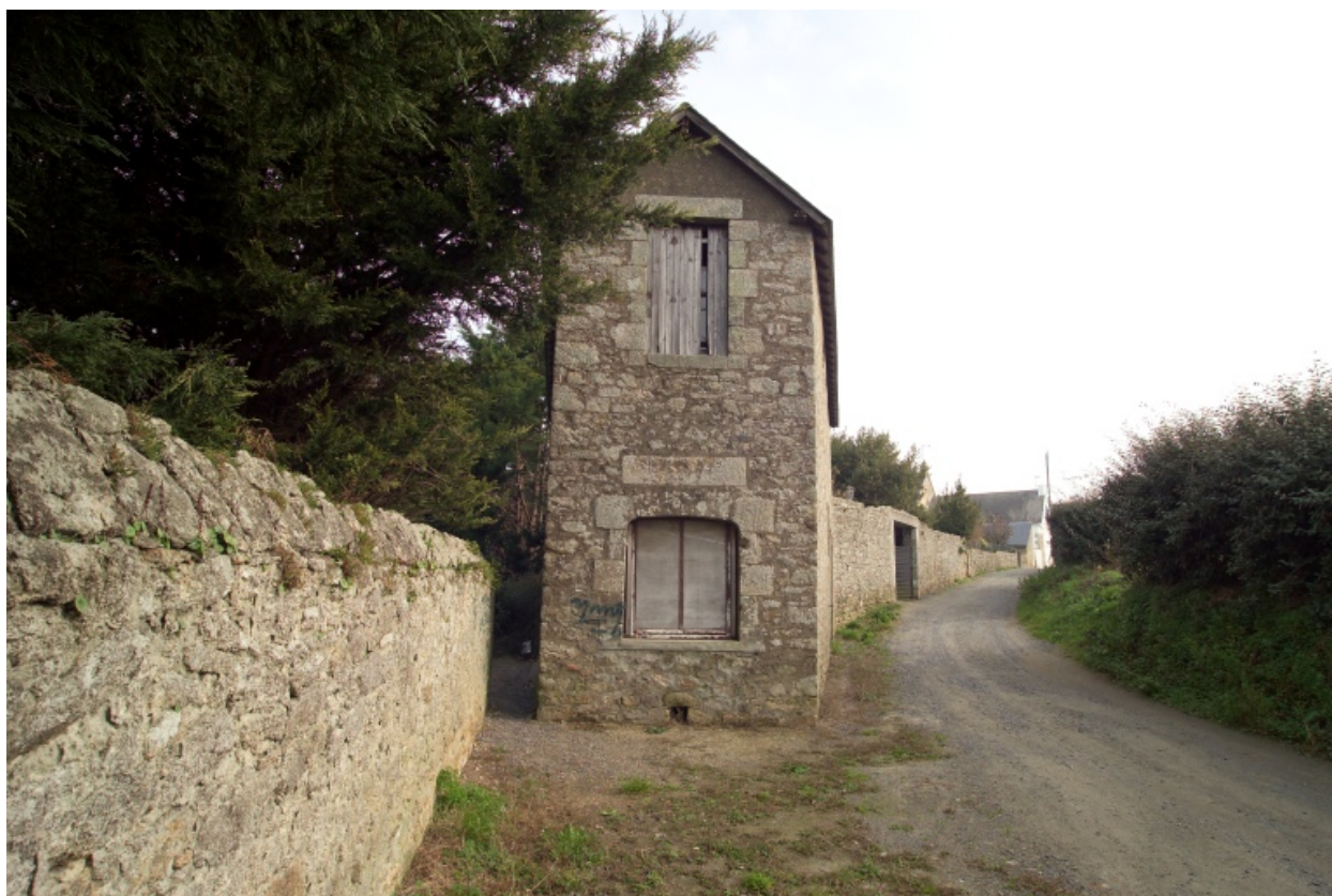
Vue vers l'Est de l'ancien atelier.
