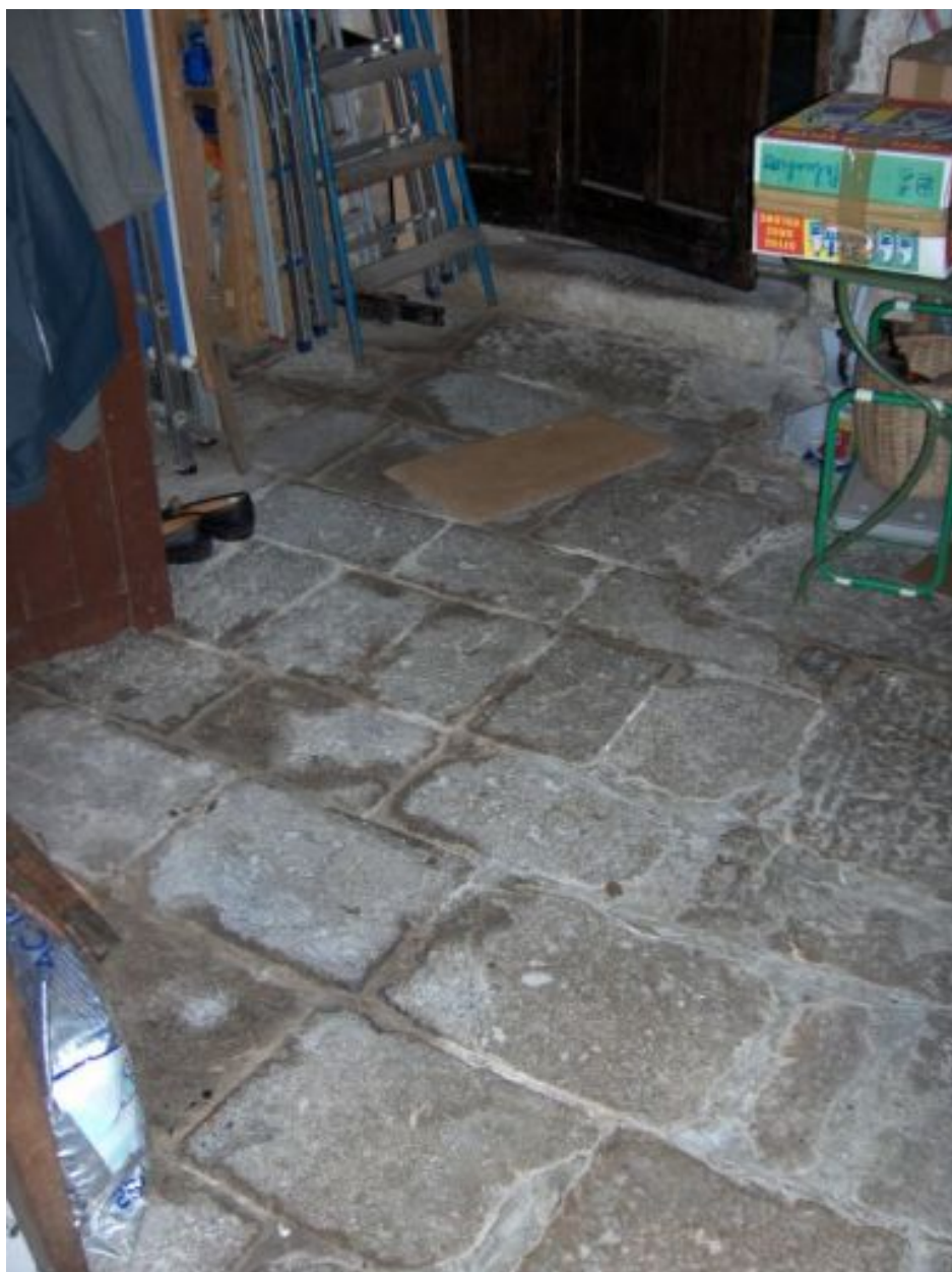
Pavage en granite du sous-sol.
