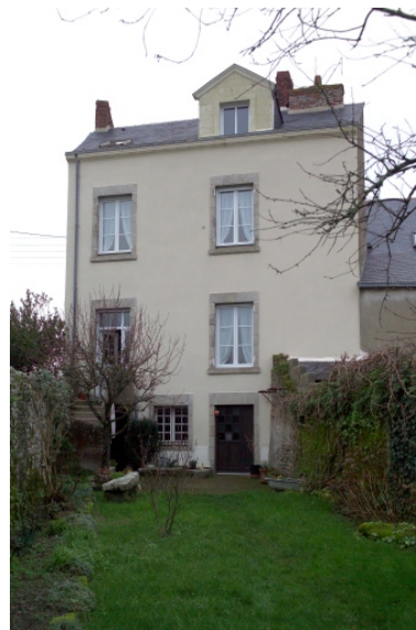
Façade postérieure de la maison du maître d'exploitation. Phot. Denis Pillet IVR52_20074400264NUCA
