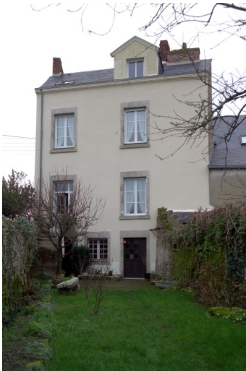
Façade postérieure de la maison du maître d'exploitation.
