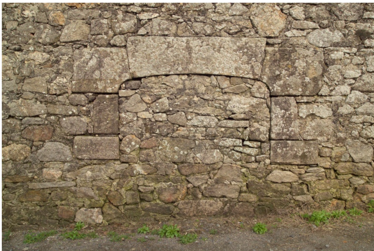
Ouverture murée du mur de clôture.
