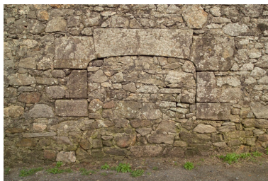
Ouverture murée du mur de clôture. Phot. Denis Pillet IVR52_20074400083NUCA
