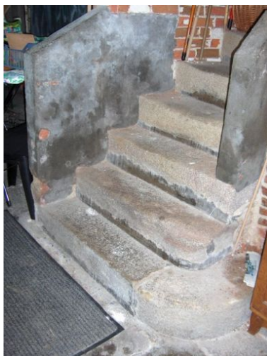
Escalier en granite du sous-sol. Phot. Frédéric Dufrêche IVR52_20074405013NUCA
