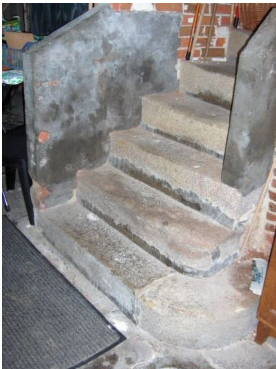
Escalier en granite du sous-sol.
