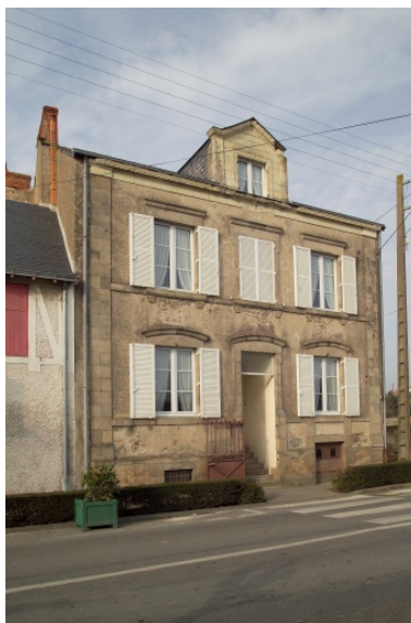
Maison du maître d'exploitation vue depuis la rue du faubourg Saint-Armel. Phot. Denis Pillet IVR52_20074400081NUCA
