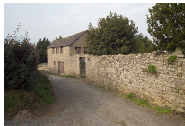
Vue vers l'Ouest de l'ancien atelier est du mur de clôture. Phot. Denis Pillet IVR52_20074400082NUCA
