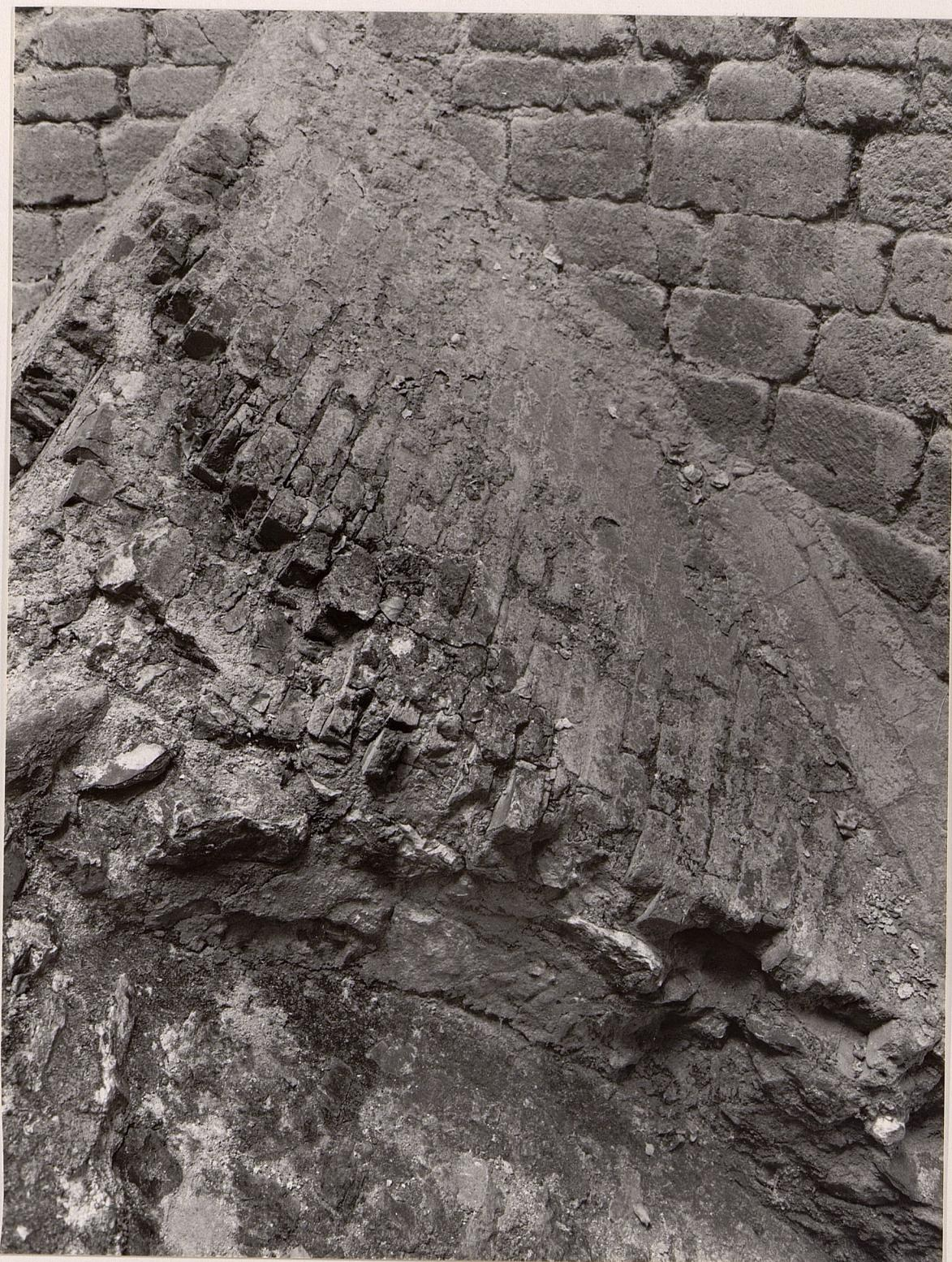
Fig. 8 : four de Clermont ; intérieur de la chambre de combustion. Vue verticale de bas en haut. Robe en pierre de Saint Pierre du Chemin.
