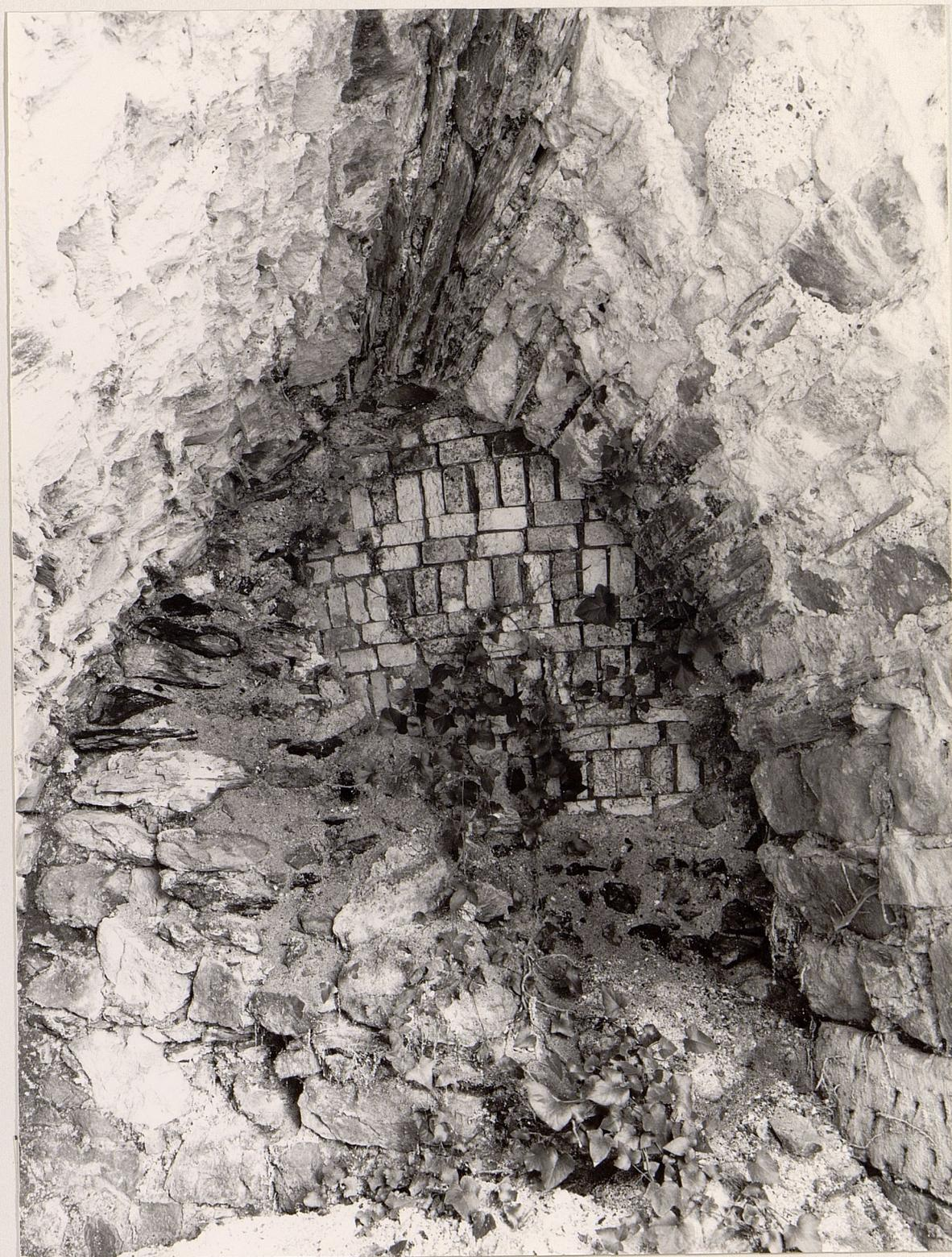
Fig. 6 : massif des fours, partie Est : fond de l'ébraisoir central en canonnière muré lors de la 2e campagne et goulotte de chargement des wagonnets en fonte. Vue de bas en haut depuis la voûte segmentaire du sous-bassement.
