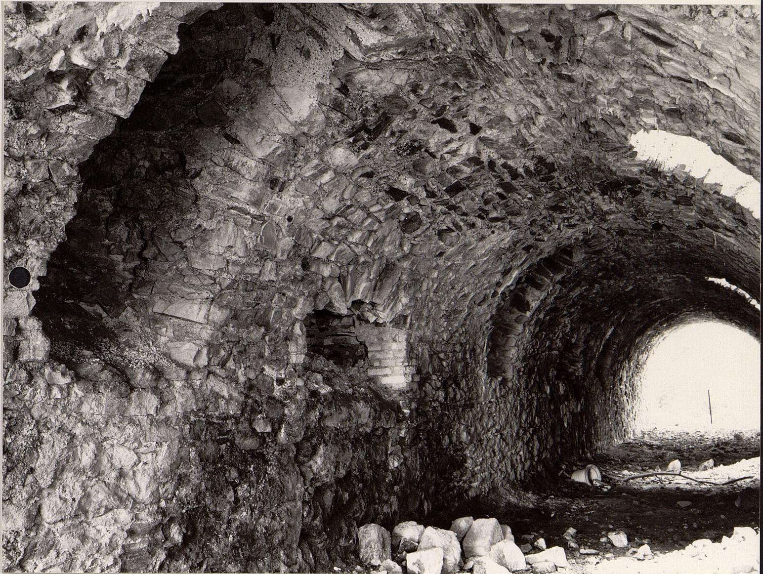
Fig. 12 : grande galerie transversale, paroi sud-ouest. Porte murée d'un des quatre fours à chaux postérieurs.
