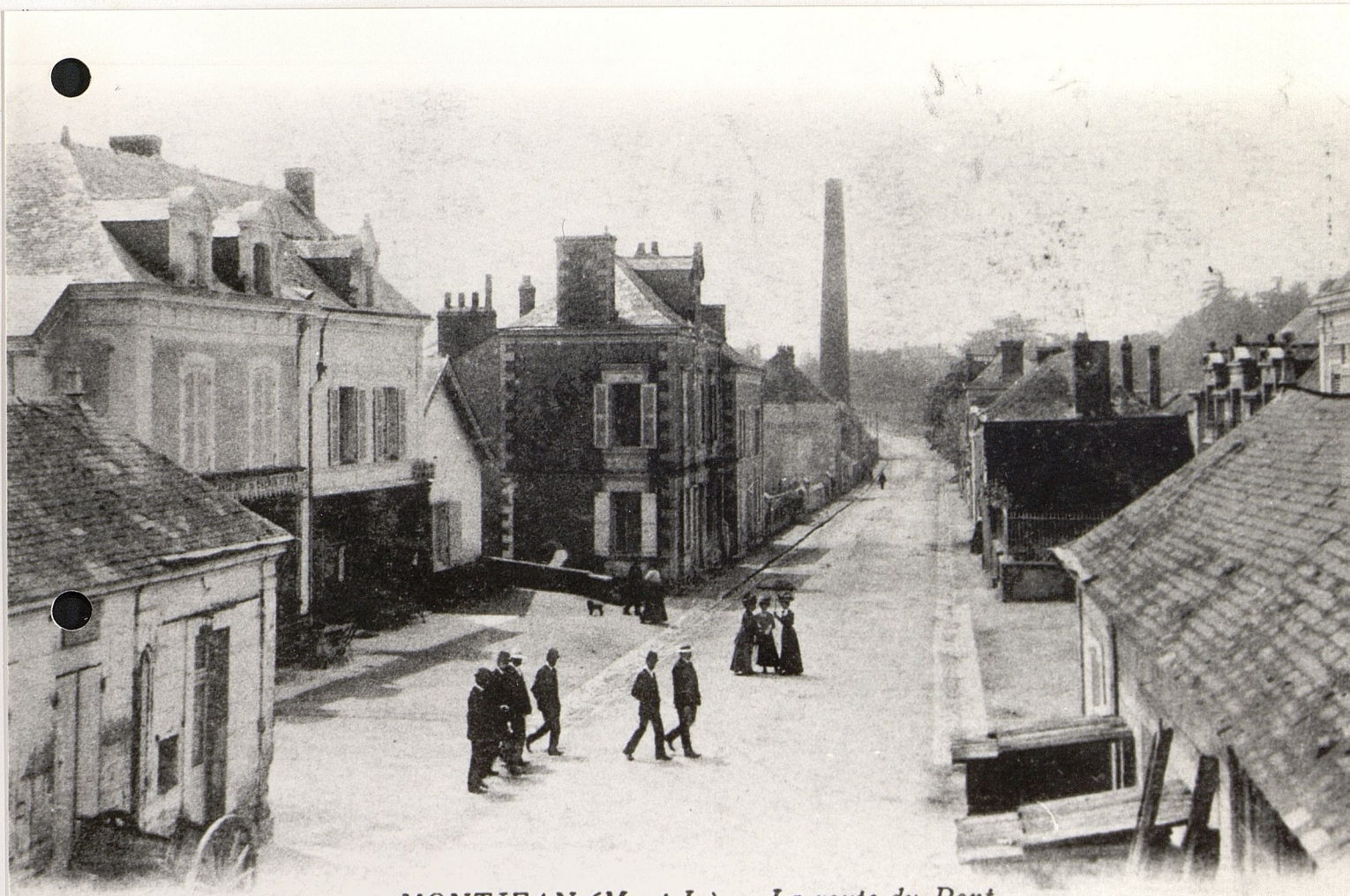
4 MONTJEAN (M.-et-L.) — La route du Pont
